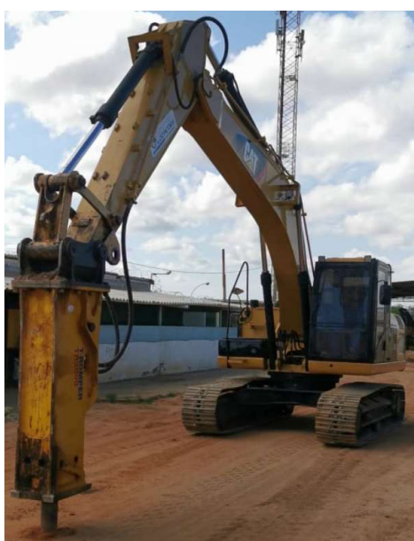
Figura 13: Escavadeira hidráulica com rompedor
