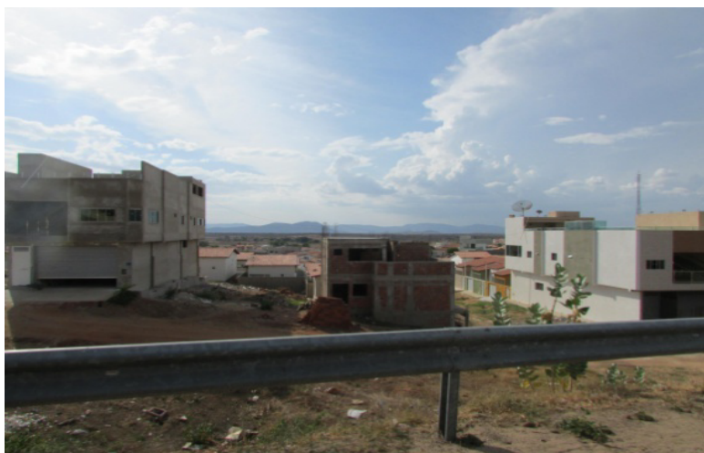
Figura 06 – Terrenos que cederam espaços para construções no Bairro Zeca Pedro
