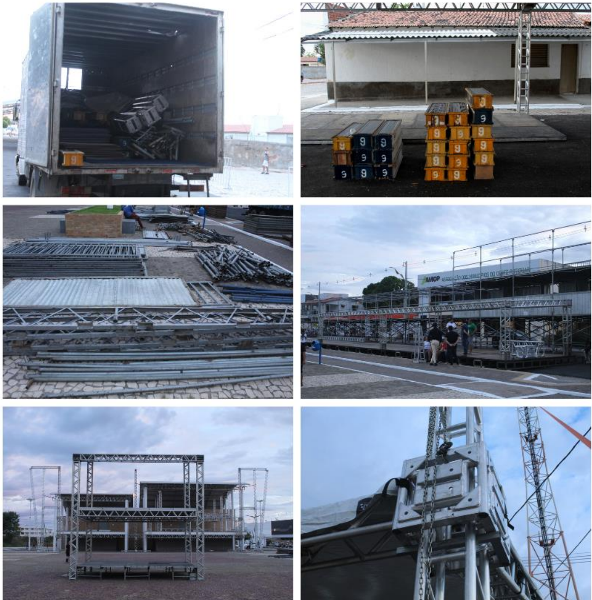
Figura 45 - Processo de montagem das instalações da FINECAP 2022
