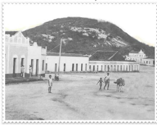
Figura 14 - Município de Catolé em processo de urbanização
