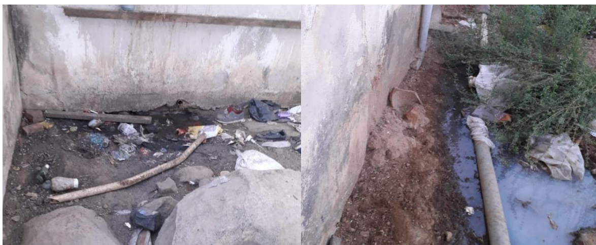
Figura 5: Despejo de águas das pias diretamente no solo na zona rural de Janduí
