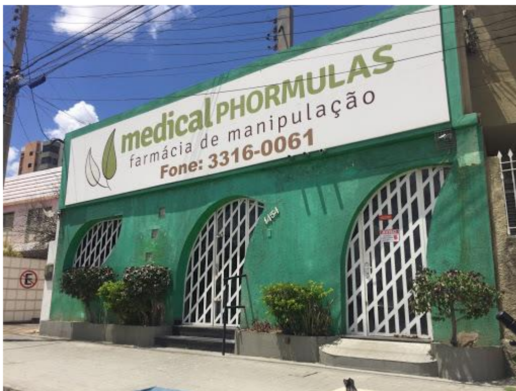
Figura 1 - Fachada da empresa
