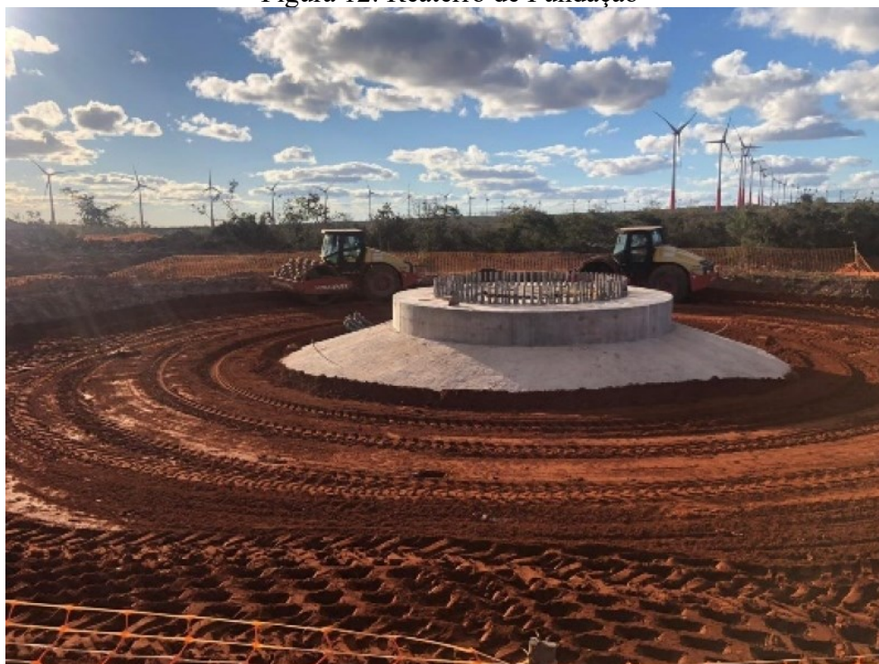
Figura 12: Reaterro de Fundação
