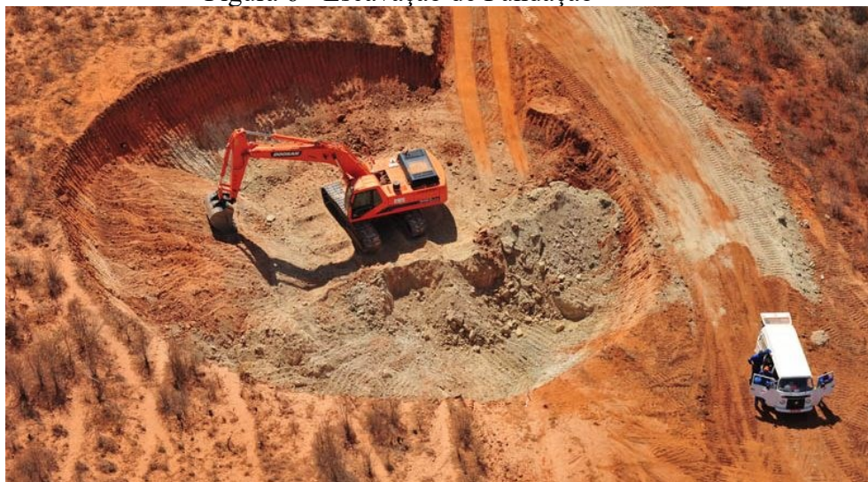
Figura 6 - Escavação de Fundação
