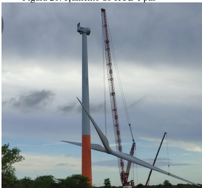
Figura 20: Içamento do HUB e pás
