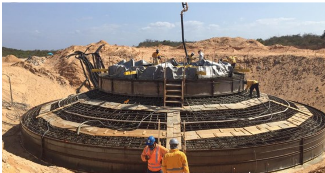
Figura 11: Execução de Concretagem da Fundação
