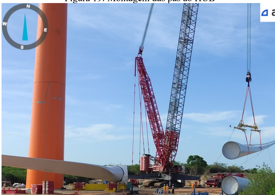
Figura 19: Montagem das pás ao HUB
