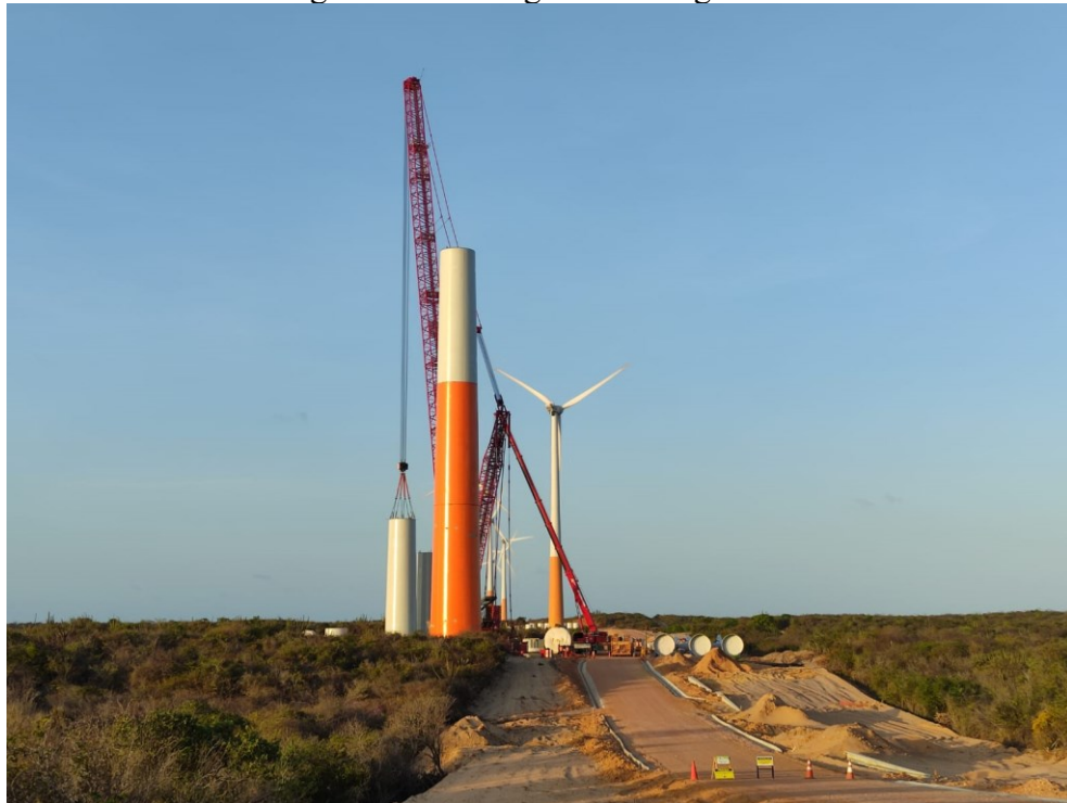
Figura 13: Montagem de aerogerador
