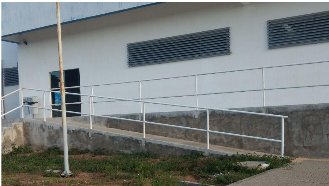
Figura 21 – Rampa atual da Biblioteca
