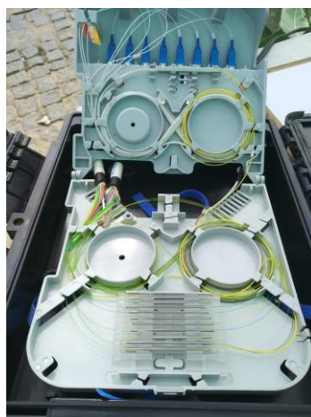
Figura 36 – Caixa de Terminação Óptica (CTO).
