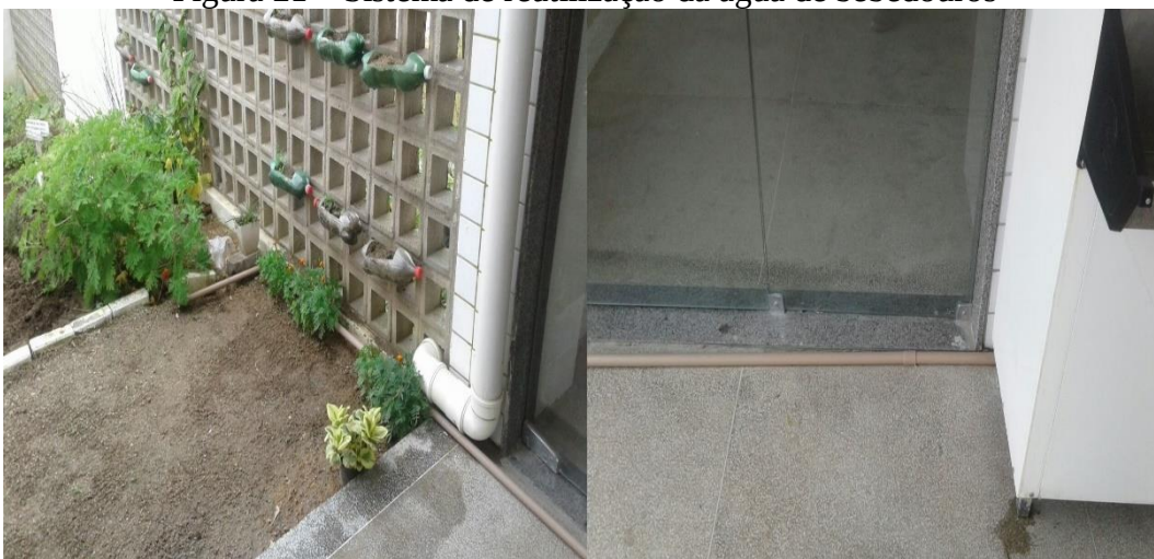
Figura 21 – Sistema de reutilização da água de bebedouros
