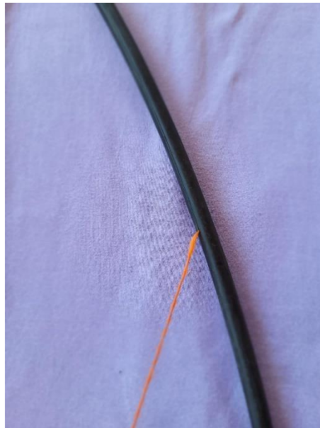
Figura 3.2: Retirada do guia para facilitar a abertura no cabo, neste caso o de 2 fibras
