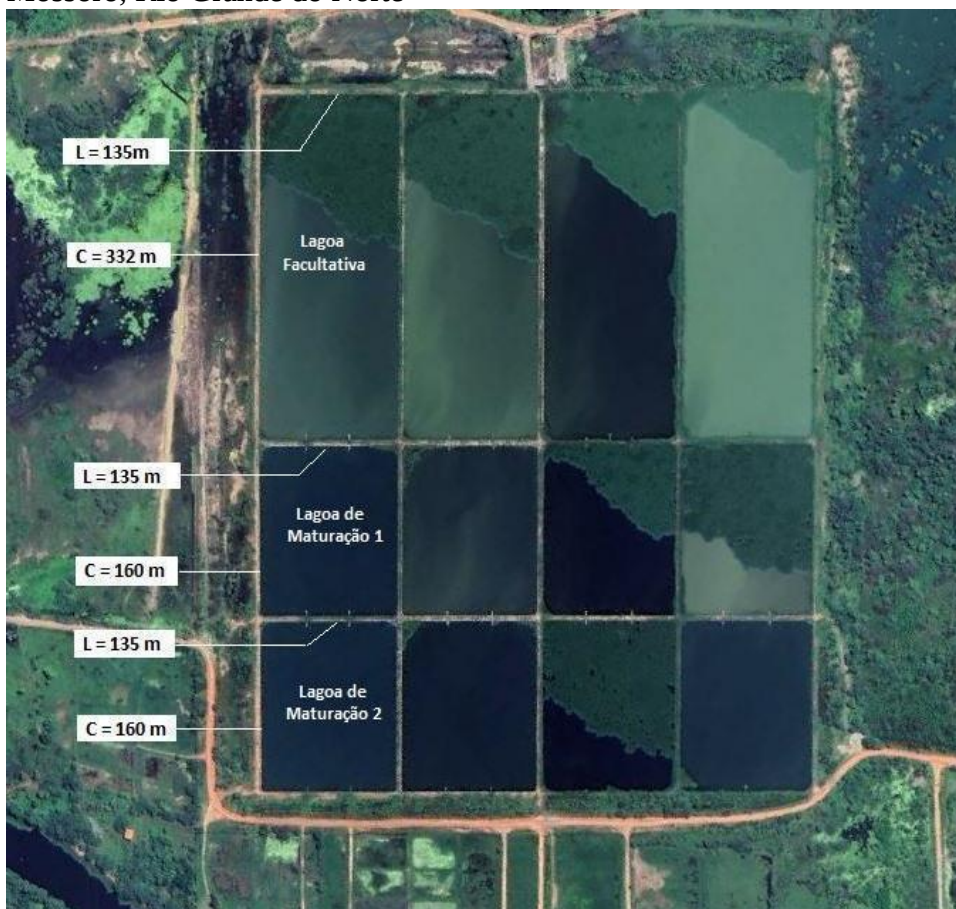
Figura 4 – Vista superior da Estação de Tratamento de Esgoto Cajazeiras, no município de Mossoró, Rio Grande do Norte
