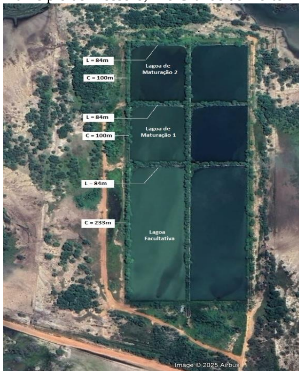
Figura 8 – Vista superior da Estação de Tratamento de Esgoto Passagem de Pedras/Rincão, no município de Mossoró, Rio Grande do Norte
