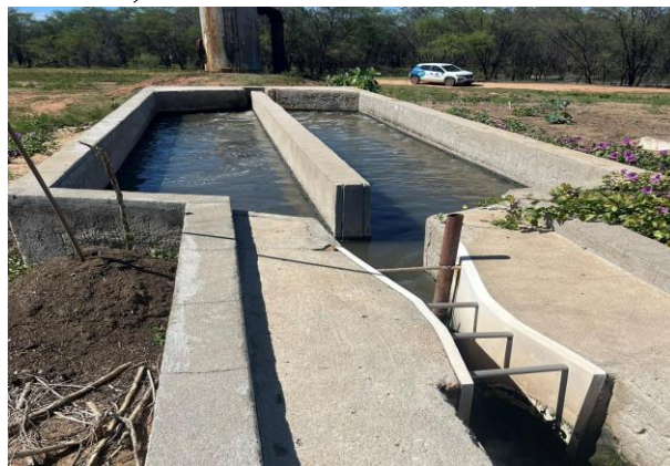
Figura 10 – Tratamento preliminar por caixa de areia, seguido de medidor de vazão (calha Parshall ), na Estação de Tratamento de Esgoto Passagem de Pedras/Rincão, município de Mossoró, Rio Grande do Norte
