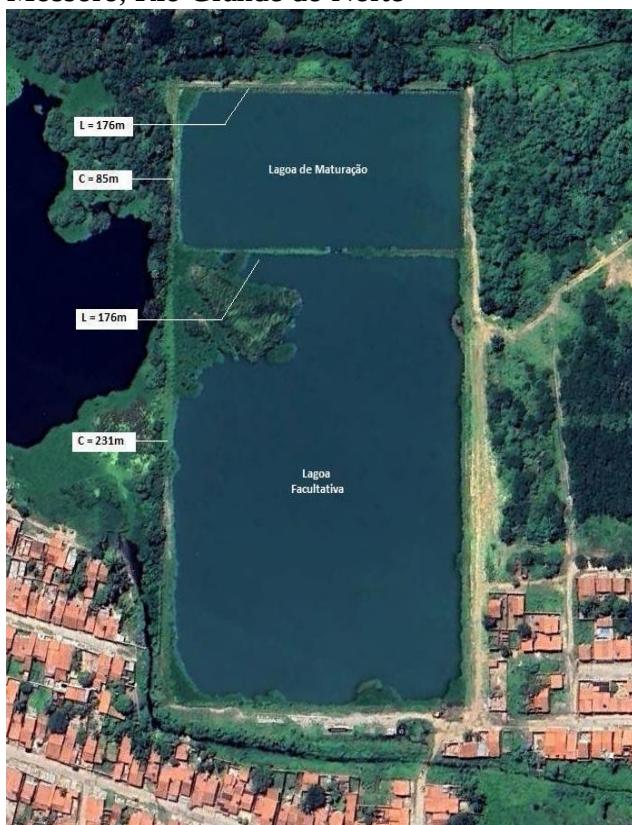
Figura 11 – Vista superior da Estação de Tratamento de Esgoto Vingt Rosado, no município de Mossoró, Rio Grande do Norte
