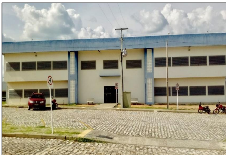
Figura 25 – Descoloração na parte externa do prédio central de aulas III. Ano 2018.
