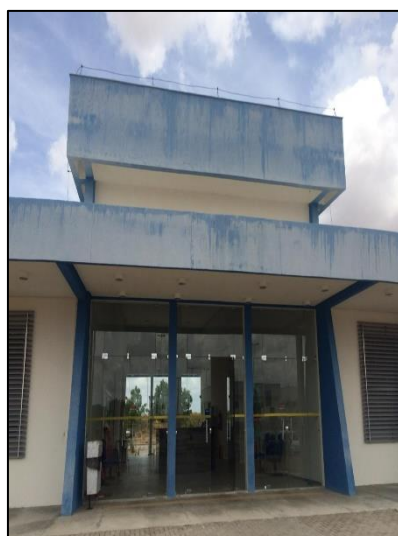
d. Descoloração. Parte externa do Bloco Administrativo.
