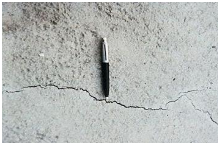
Figura 4 – Fissura.
