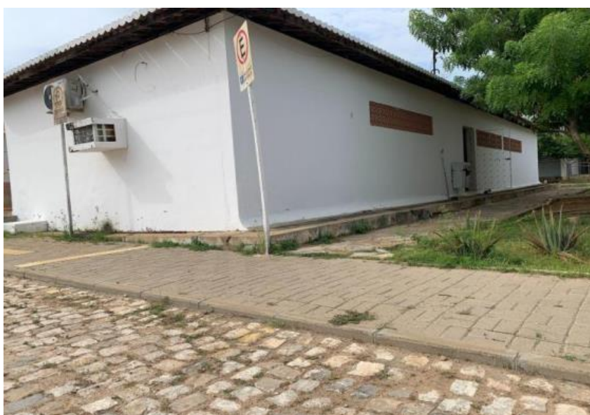
Figura 3 – Laboratório de Microbiologia Veterinária (LAMIV).
