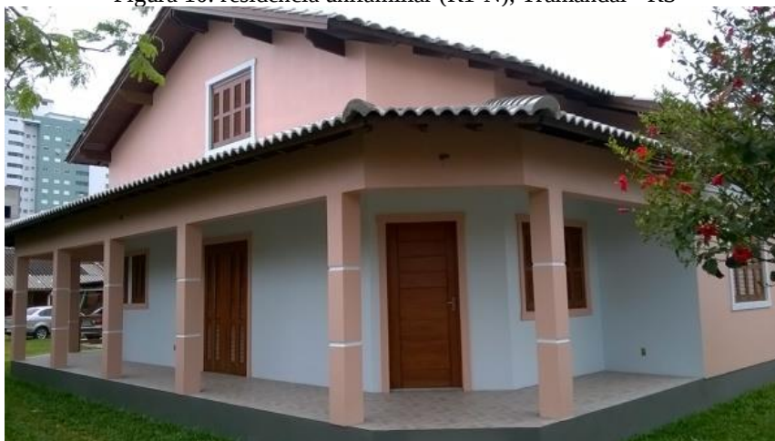
Figura 10: residência unifamiliar (R1-N), Tramandaí - RS
