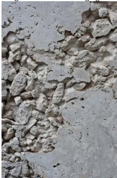
Figura 9: Concreto desagregado.
