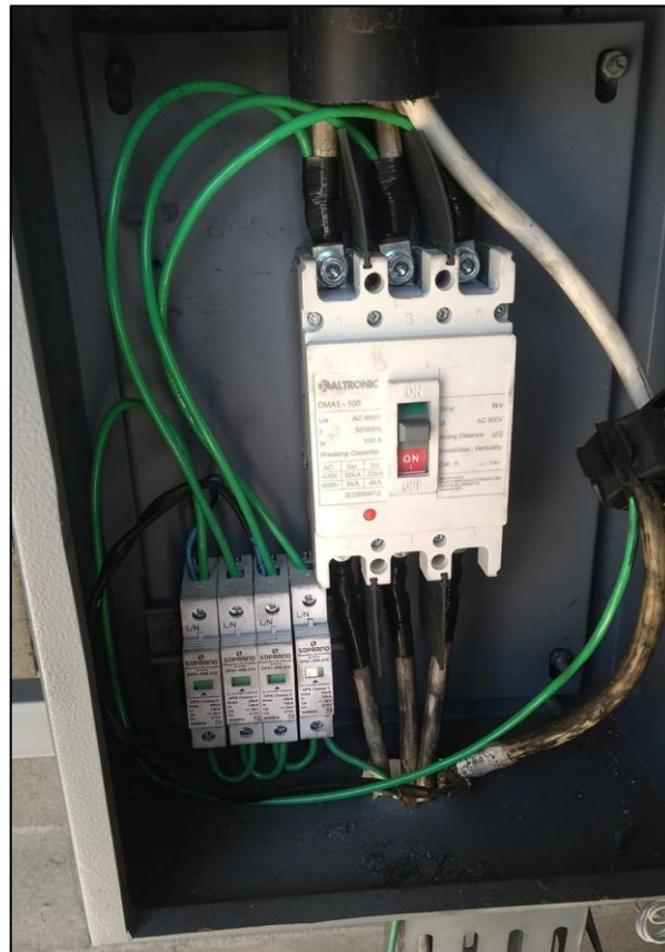
Figura 34 - Registro da restauração da string box do inversor.
