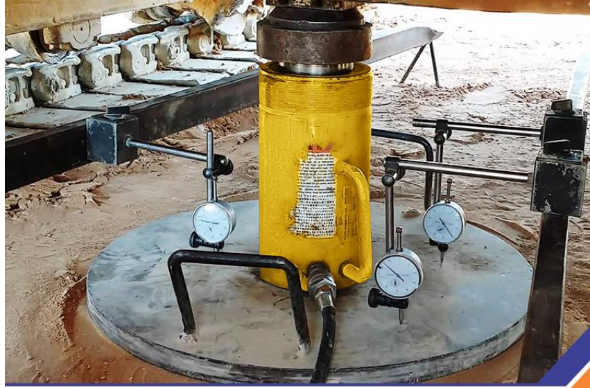
Figura 3 – Exemplo de uma prova de carga em placa em execução.
