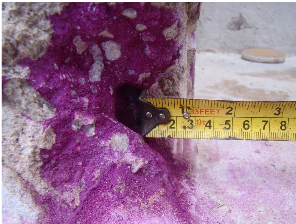
Figura 7: Medindo a profundidade da frente de carbonatação.
