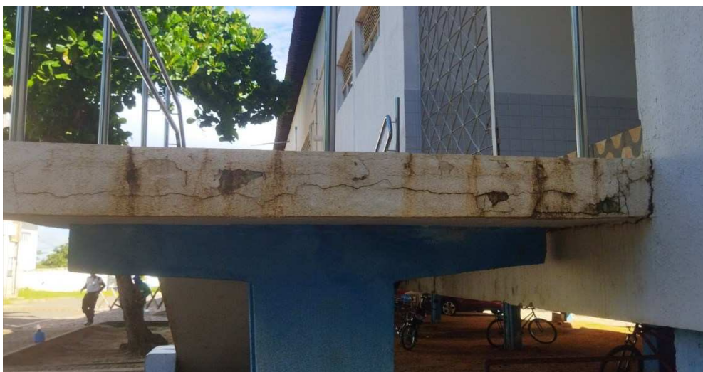
Figura 30: Escada lateral que dar acesso a edificação.
