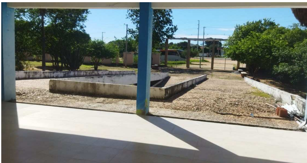
Figura 29: Rampa de acesso a edificação.
