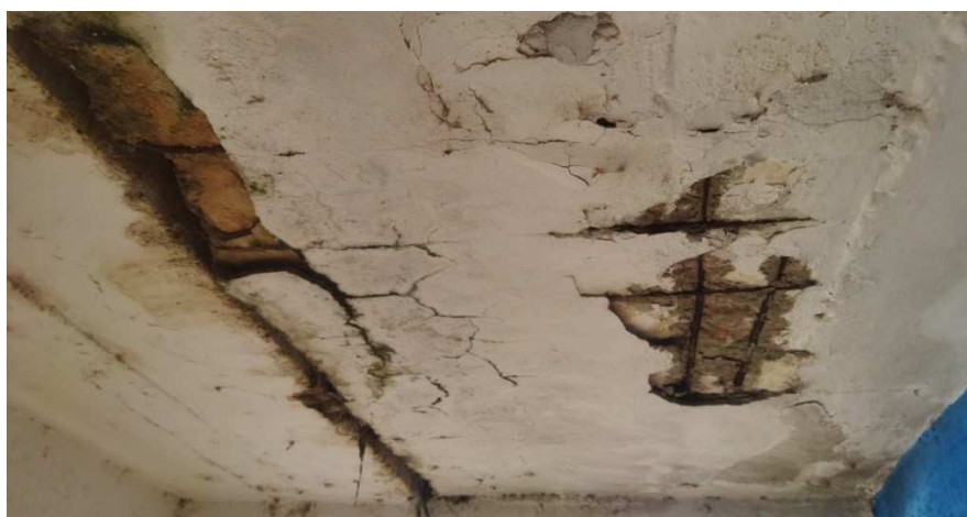
Figura 9: Armadura exposta.
