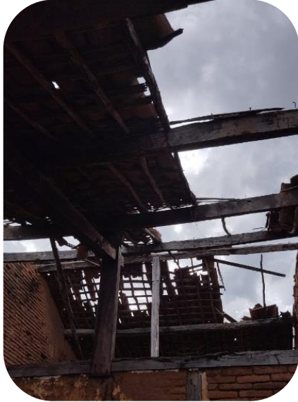
Figura 11 – Estrutura do telhado
