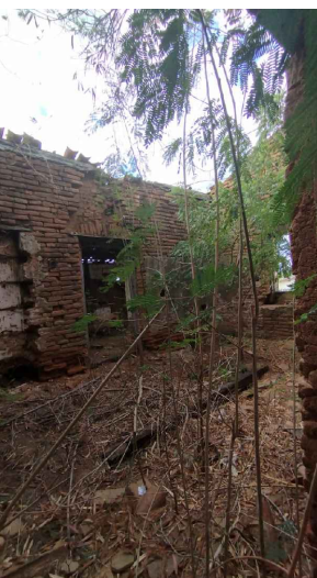
PAREDE DE ADOBE: SALA
