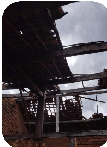
Figura 45 – Estado atual do edifício
