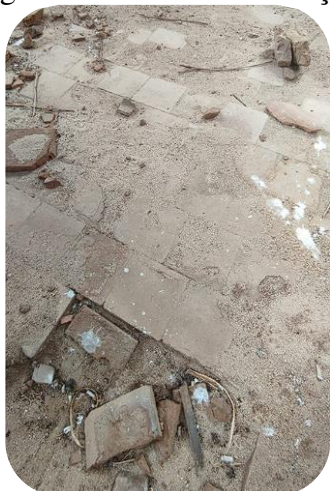
Figura 44 – Piso da edificação
