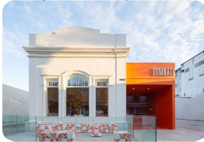
Figura 38 – Fachada original e anexo
