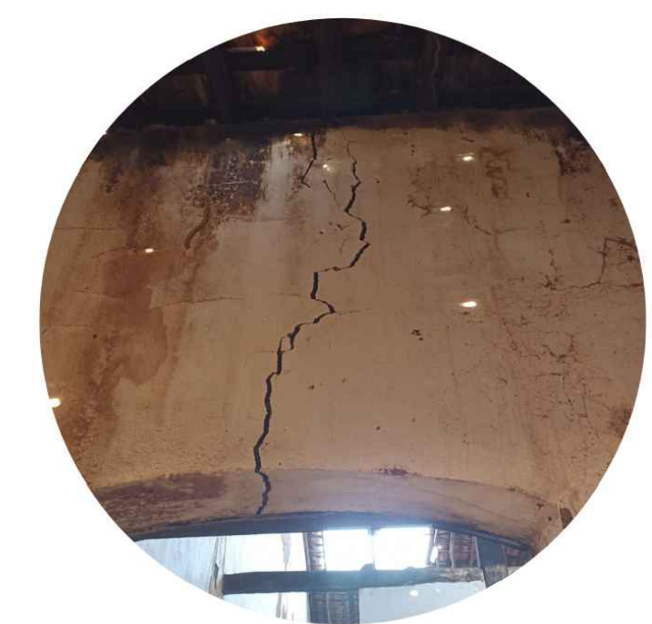
FOTO 02 - RACHADURA - COZINHA
