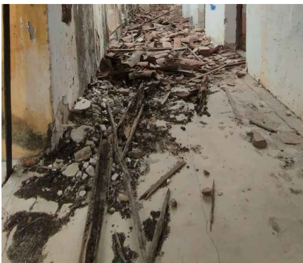
PISO GUARITA: CIMENTO QUEIMADO
