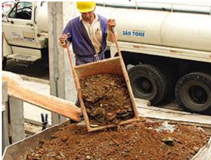
Figura 2. Resíduos de Construção Civil – Classe A.
