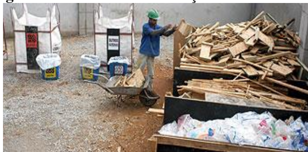
Figura 3. Resíduos de Construção Civil – Classe B.
