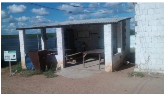
Figura 9: Refeitório com quadro de aviso e exemplo de local sinalizado através de placas.
