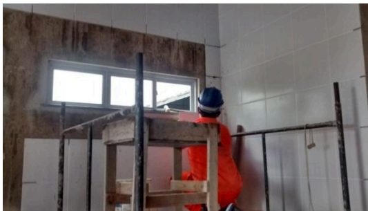
Figura 11: Operário trabalhando com equipamentos de segurança adequados.
