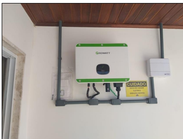
Figura: 20: Processo final da instalação do projeto.
