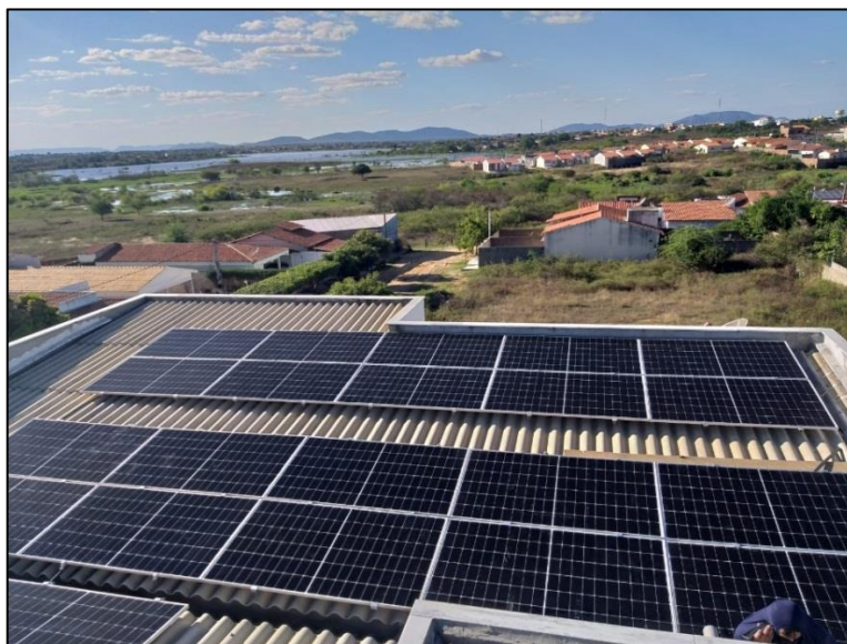
Figura 18: módulos instalados sobre os suportes.
