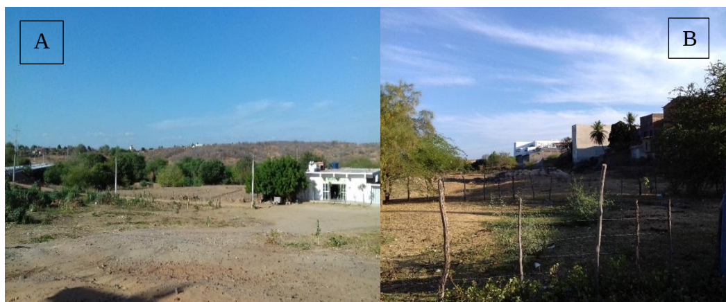
Figura 6 – A- Prédios comerciais dentro da APP. B- Construções irregulares dentro da APP.
