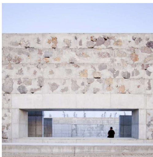
Figura 2 - Muro d concreto ciclópico
