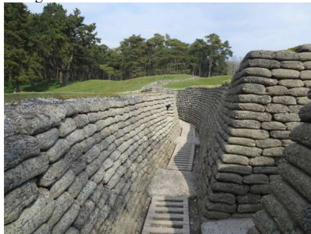
Figura 5 - Muro Solo Saco-Cimento
