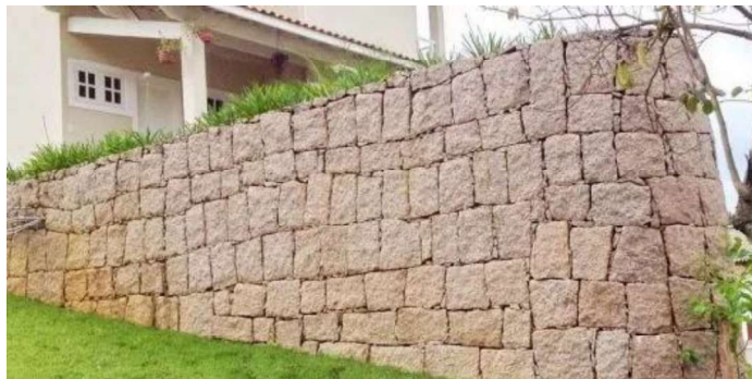
Figura 1 - Muro de alvenaria de pedra
