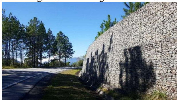
Figura 3- Muro de gabião
