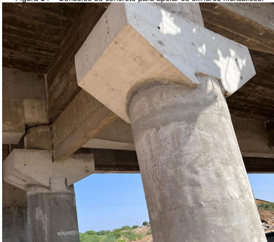
Figura 14 – Consoles de concreto para apoiar os cilindros hidráulicos.
