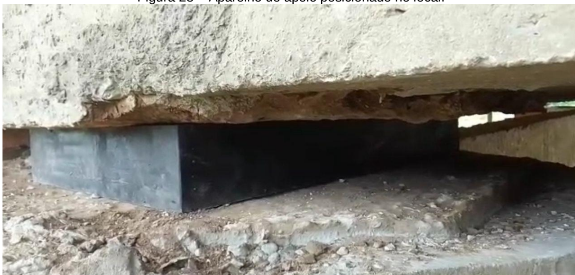
Figura 28 – Aparelho de apoio posicionado no local.
