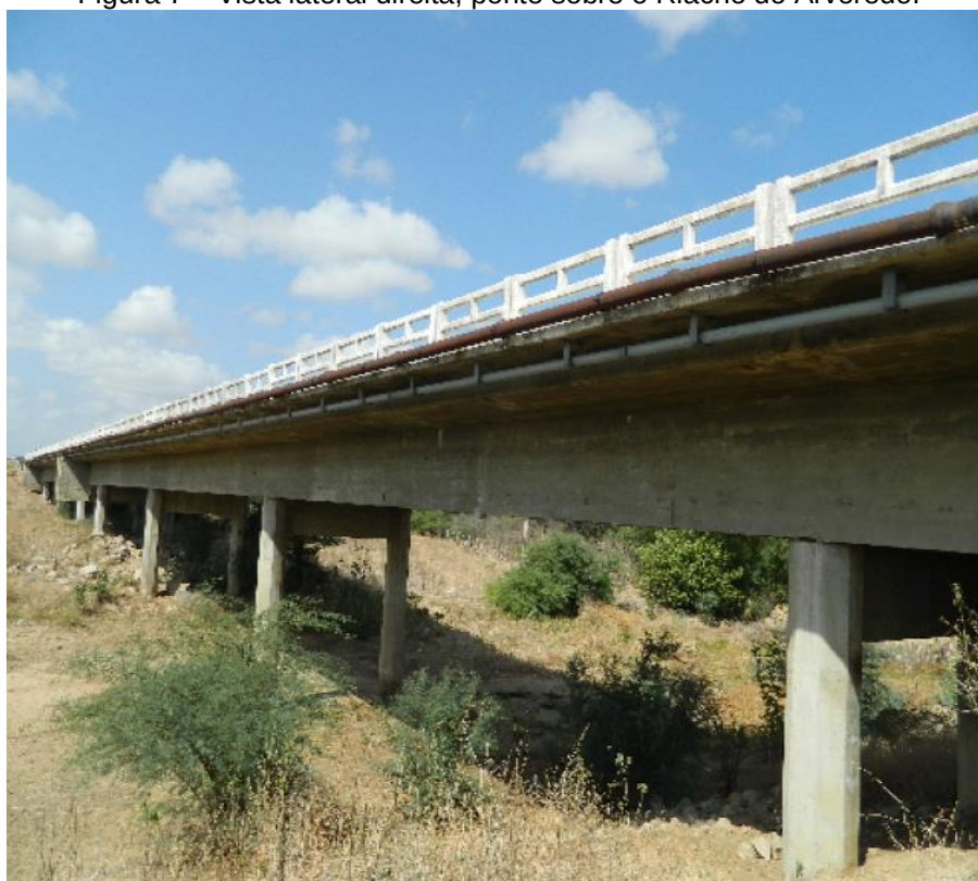
Figura 7 – Vista lateral direita, ponte sobre o Riacho do Arvoredo.
