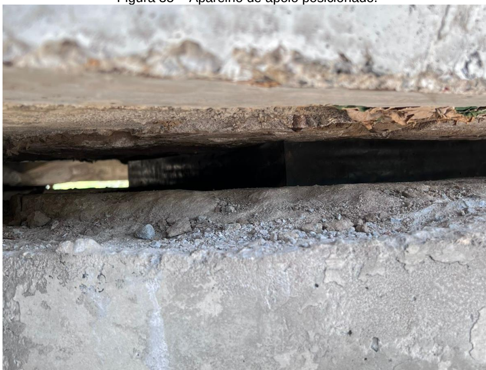
Figura 35 – Aparelho de apoio posicionado.
