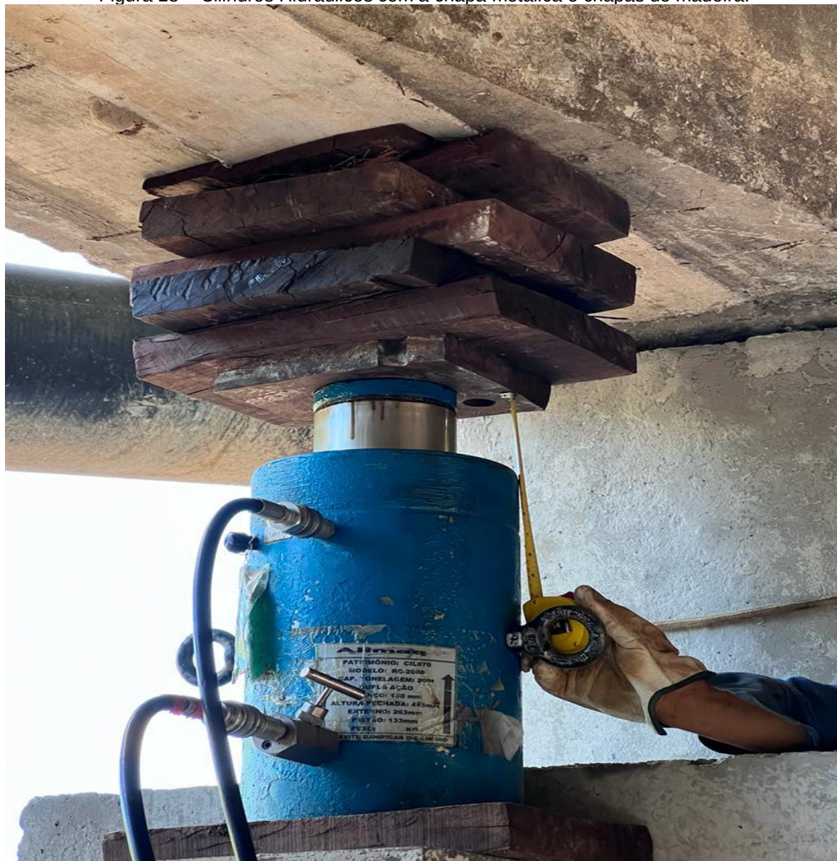
Figura 18 – Cilindros Hidráulicos com a chapa metálica e chapas de madeira.
