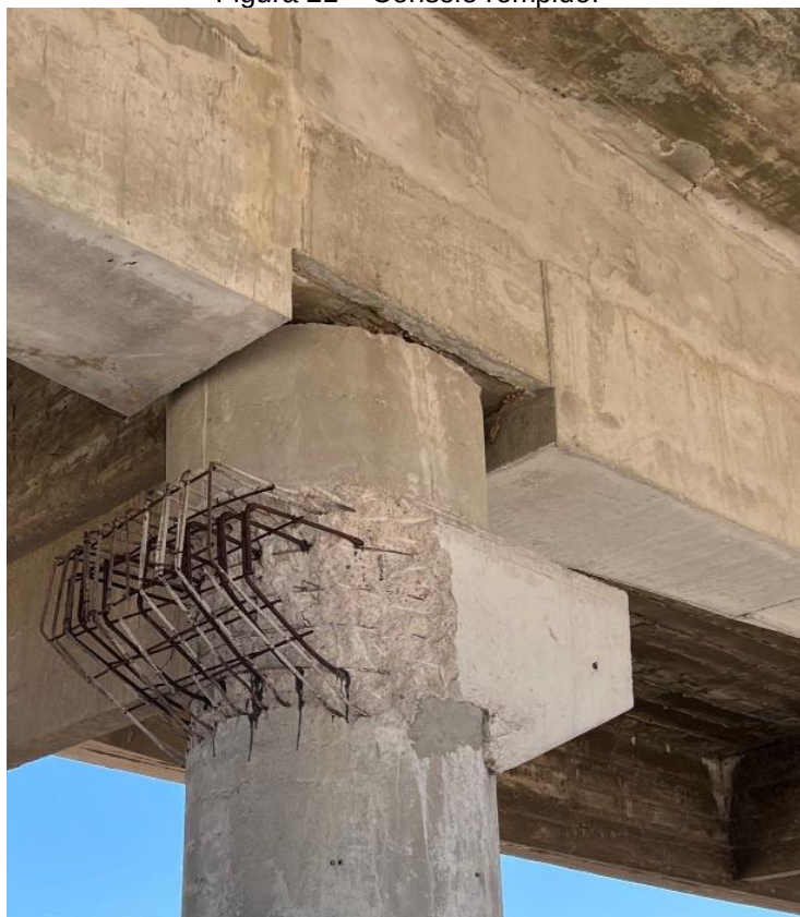
Figura 21 – Console rompido.
