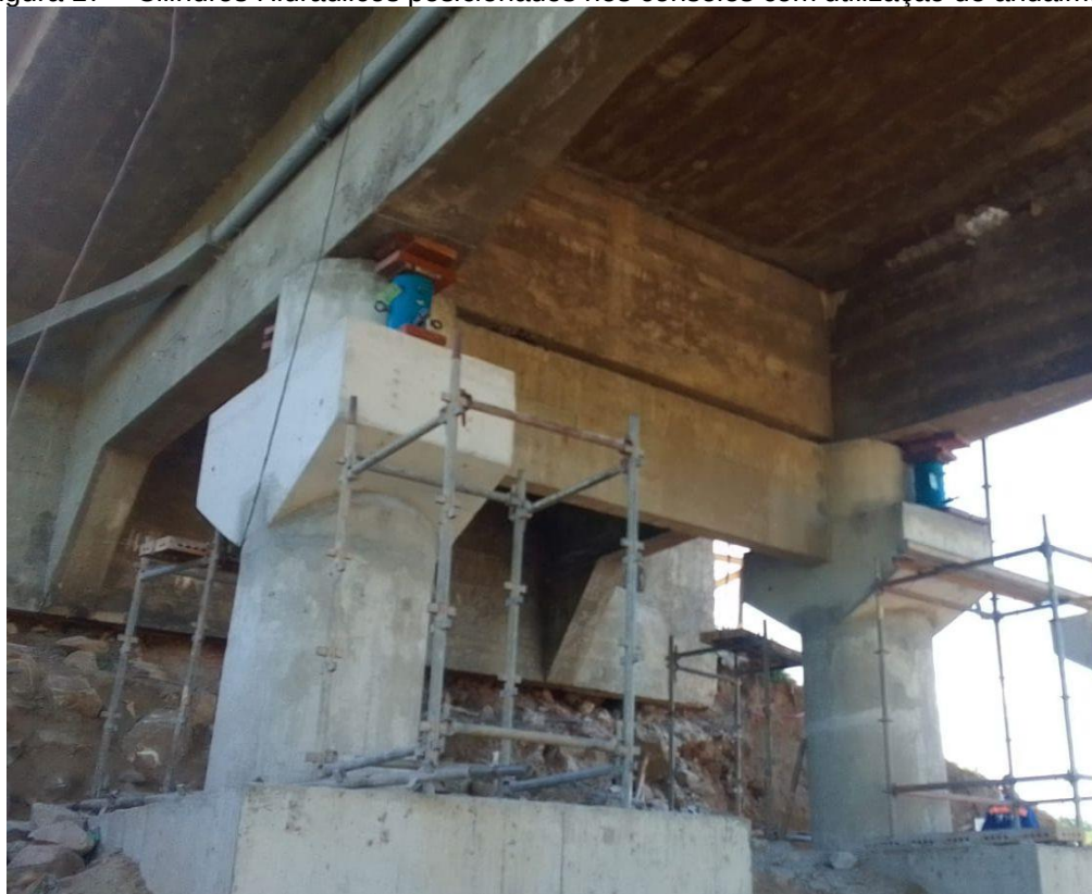
Figura 17 – Cilindros Hidráulicos posicionados nos consoles com utilização de andaimes.
