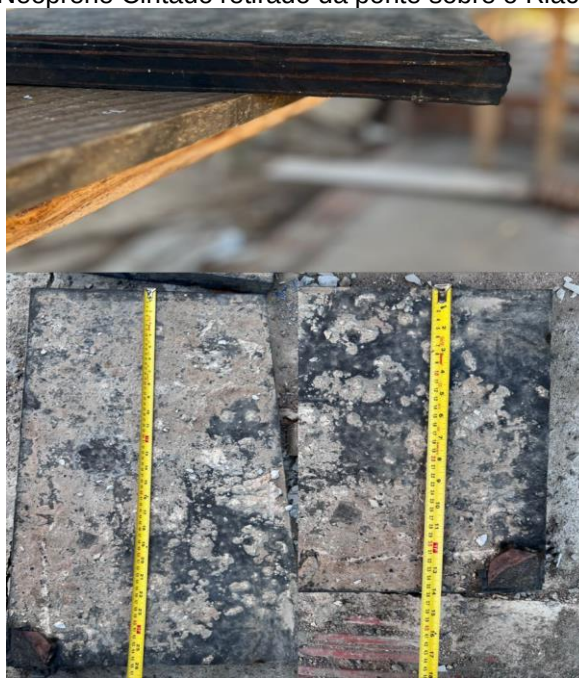
Figura 32 – Neoprene Cintado retirado da ponte sobre o Riacho de Ipueira.
