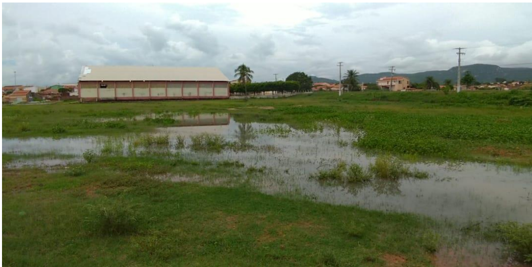
Figura 21: Acúmulo de água na área em estudo
