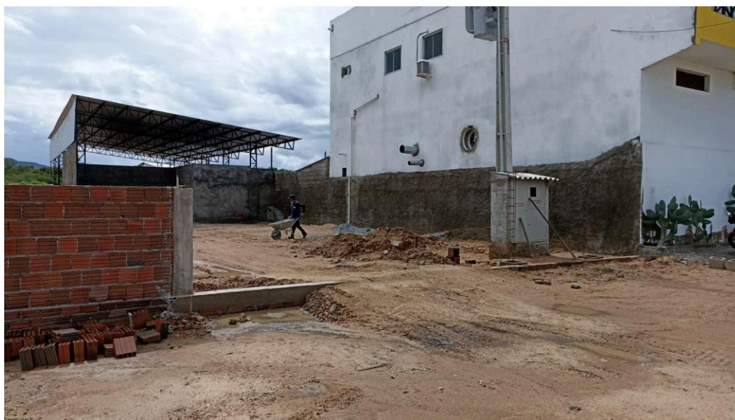
Figura 23 - Frente da oficina em construção
