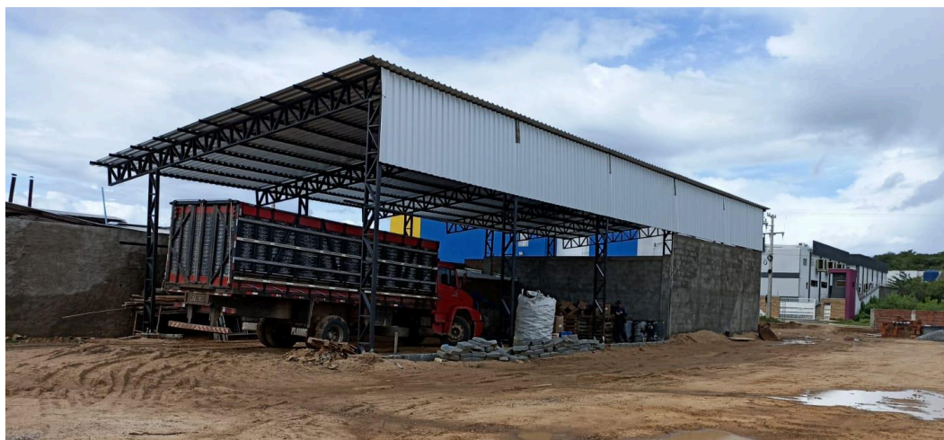
Figura 24 - Galpão da oficina em construção
