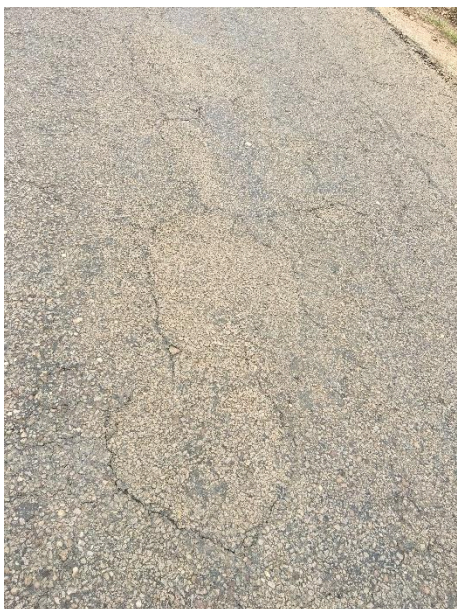
Figura 26: Afundamento local.
