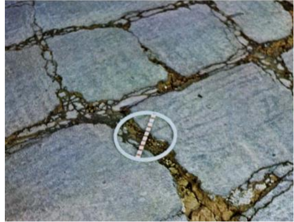
Figura 6: Trinca "Bloco".
