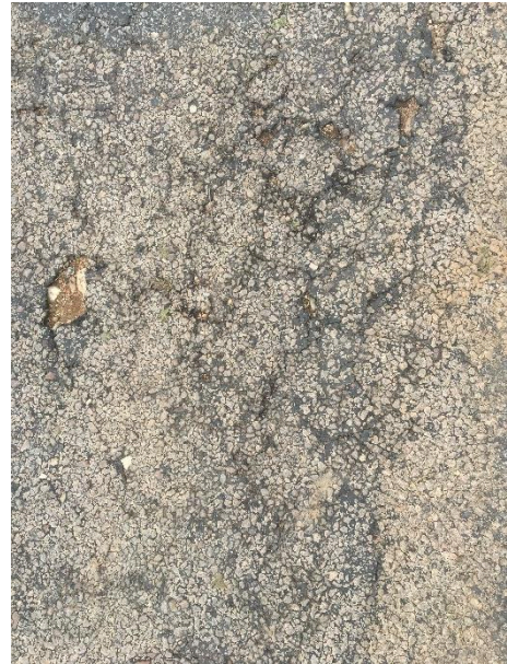
Figura 23: Trincamento por fadiga.
