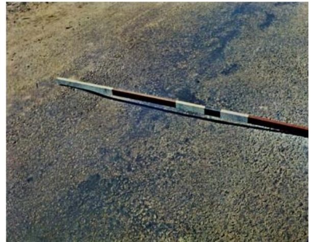
Figura 8: Afundamento local.
