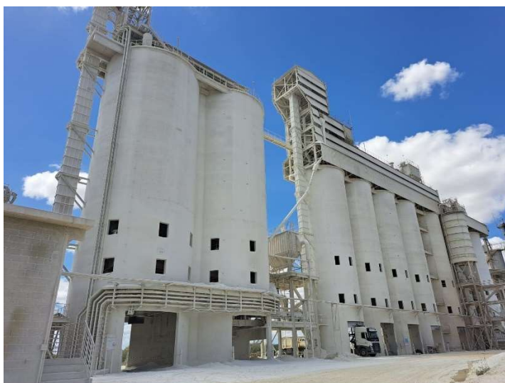
Figura 7 - Silos de estocagem da CNN.
