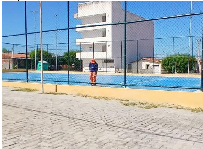
Figura 32 – Um trabalhador fazendo manutenção da quadra.
