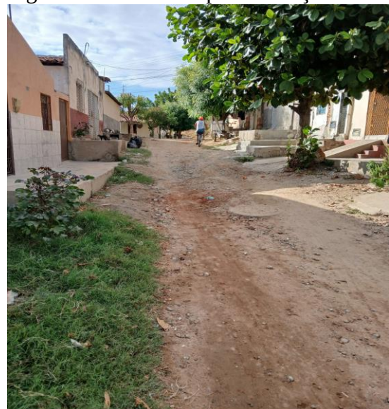
Figura 15 - Ruas sem pavimentação.
