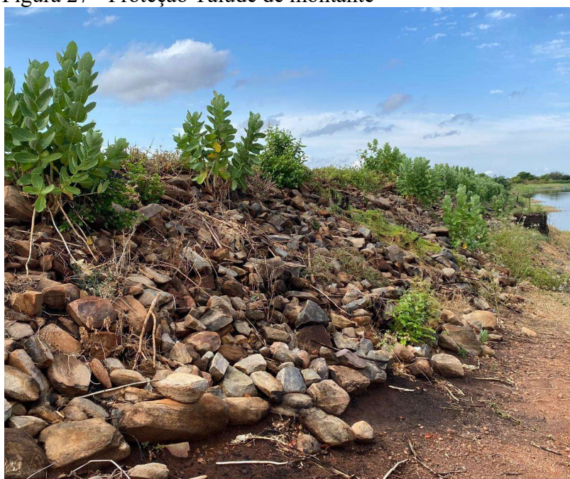
Figura 27 - Proteção Talude de montante
