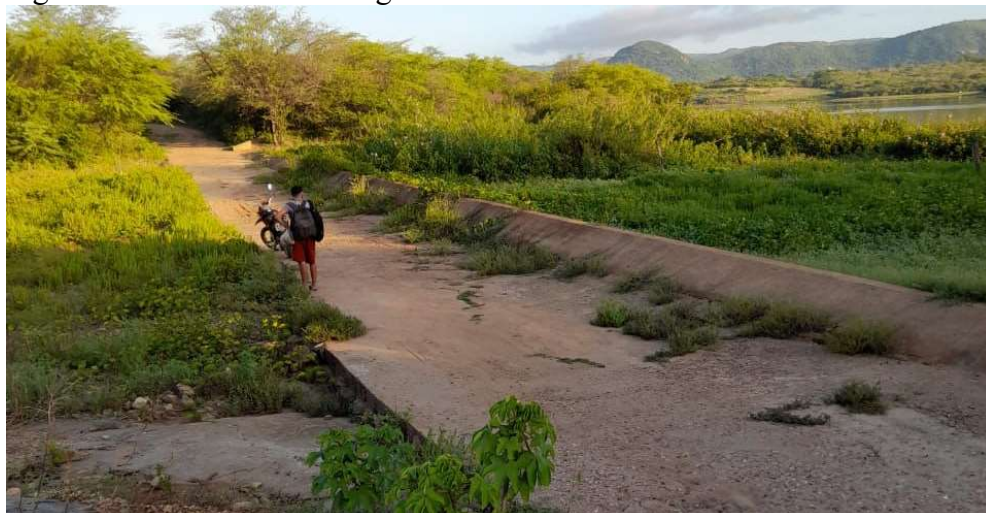
Figura 39 - Vertedouro barragem corredor
