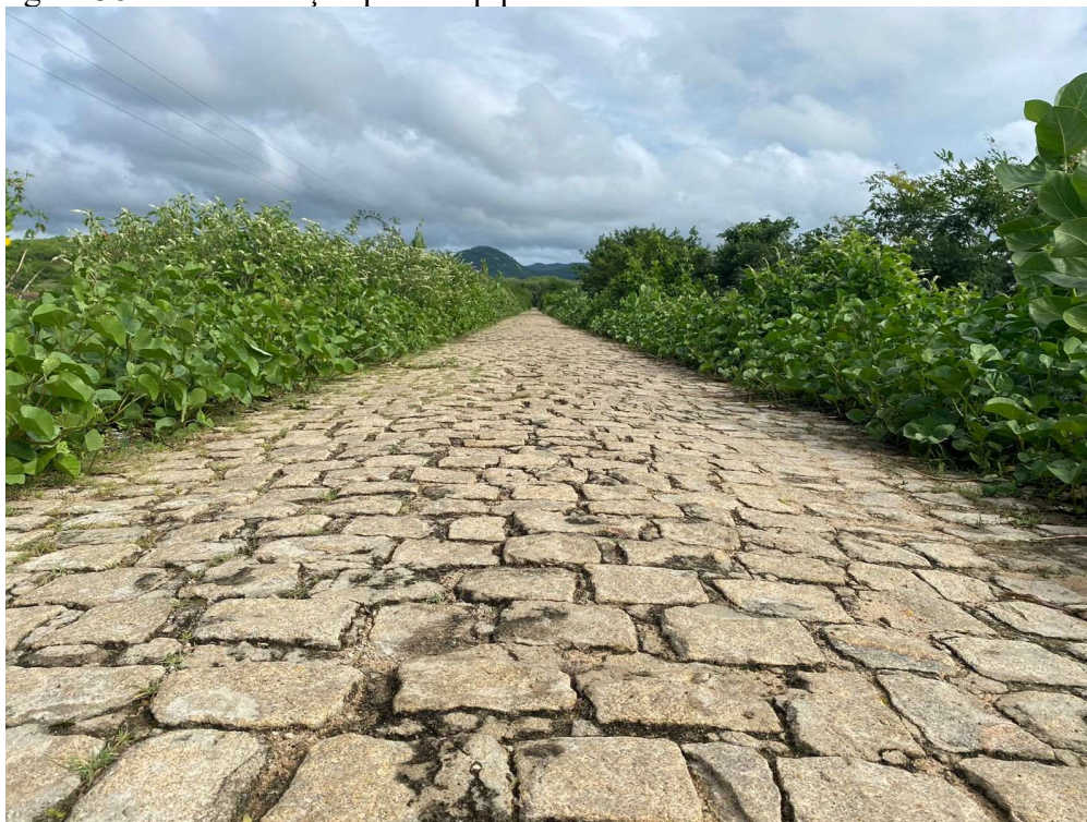
Figura 38 - Pavimentação paralelepípedo barramento corredor
