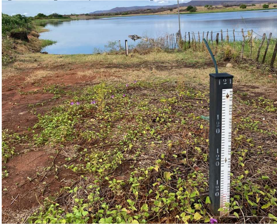
Figura 29 - Régua medição de nível de água
