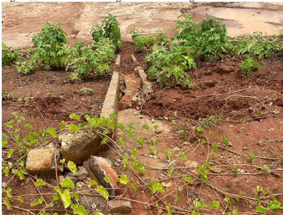
Figura 33 - Estrutura de drenagem barramento angicos
