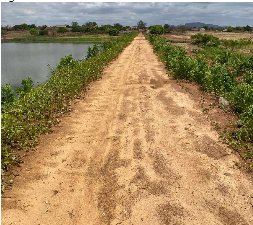
Figura 26 -Talude barramento José da Penha
