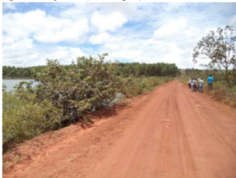
Figura 11- Representação de vegetação excessiva
