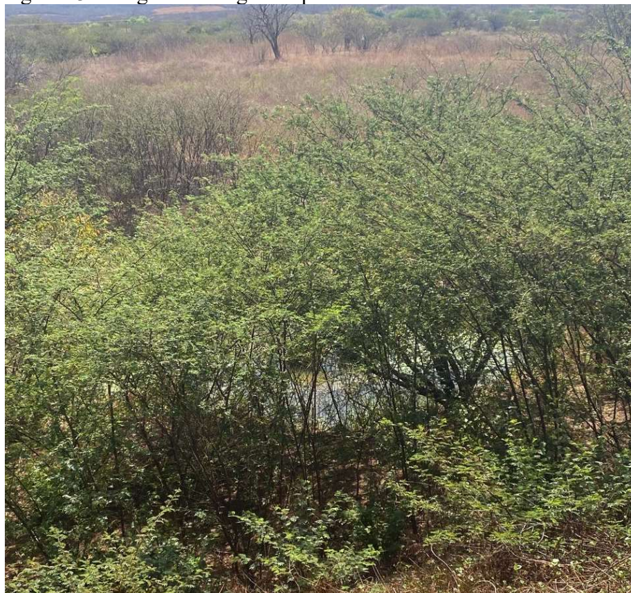
Figura 23 - Surgência de água no pé do barramento
