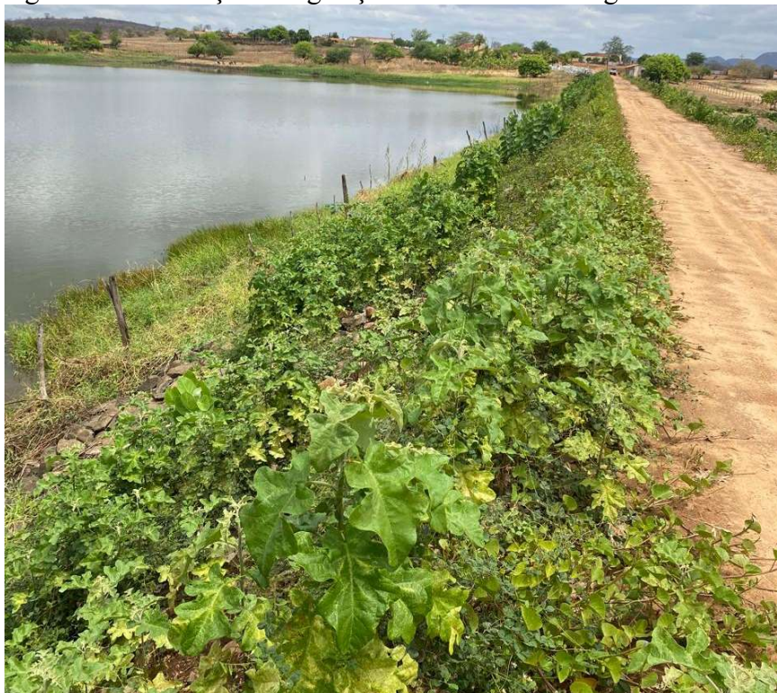
Figura 30 - Presença de vegetação no barramento angicos
