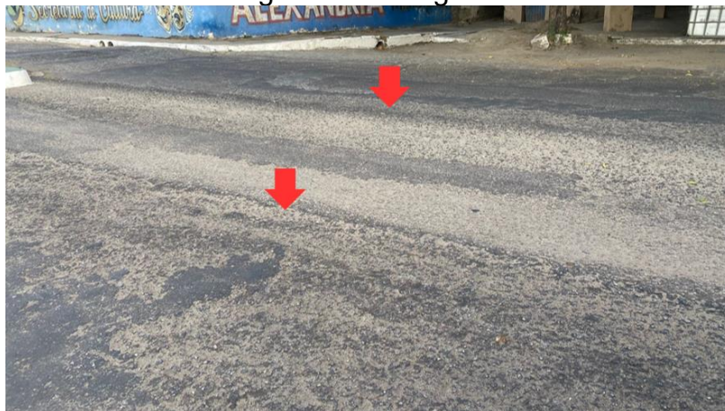
Figura 27 - Desgaste
