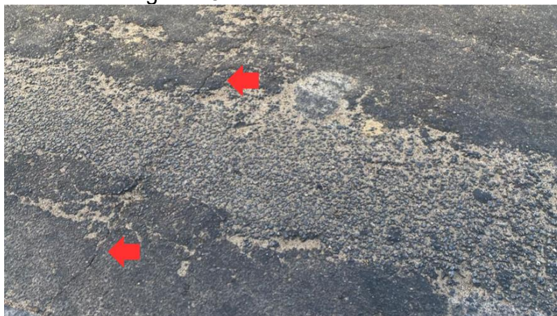
Figura 25 - Trincas transversais
