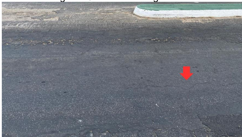
Figura 20 - Fissuras longitudinais
