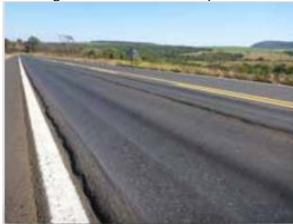
Figura 8 - Afundamento plástico
