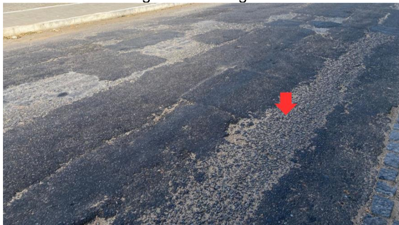
Figura 26 - Desgaste
