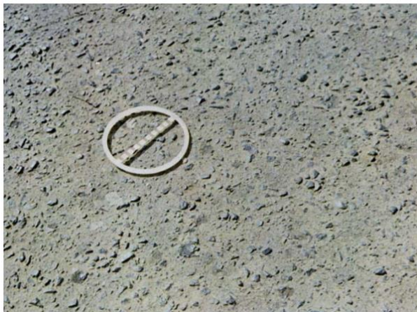
Figura 13 – Desgaste
