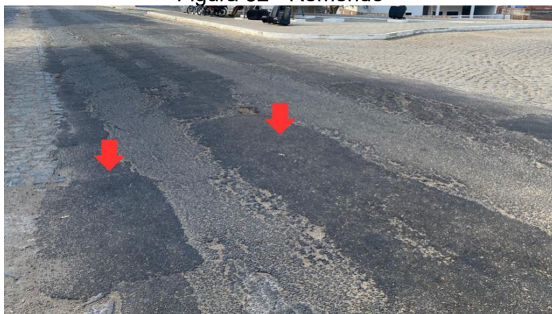
Figura 32 - Remendo
