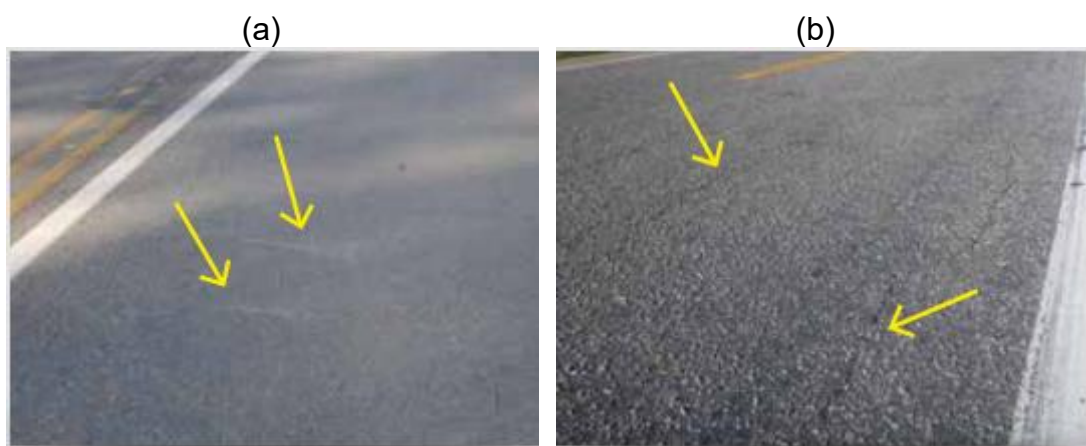
Figura 2 – Fissura
