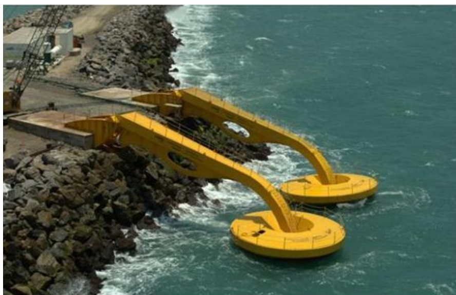
Figura 12- Projeto piloto de geração de energia elétrica através das ondas do mar no Porto de Pecém, Ceará.
