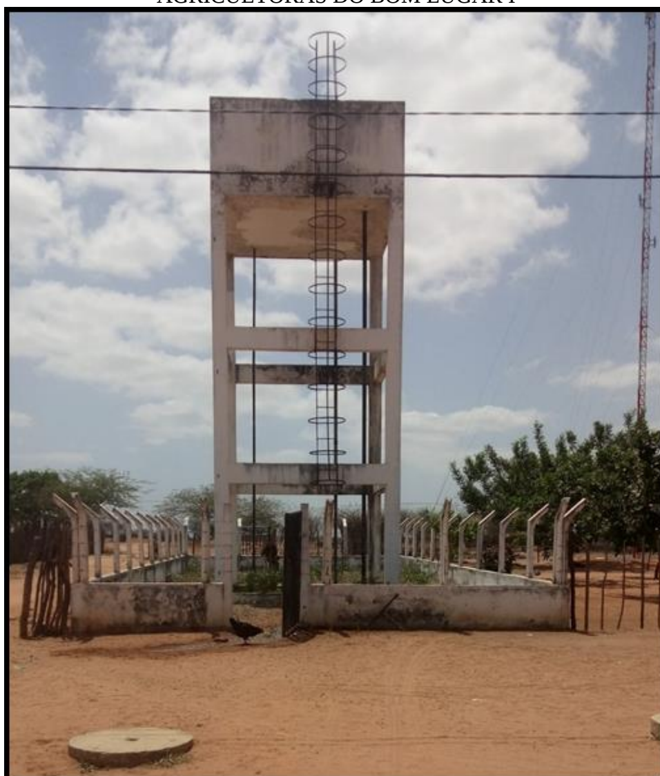
Figura 2 – CAIXA DE DISTRIBUIÇÃO D'AGUA DOS AGRICULTORES E AGRICULTORAS DO BOM LUGAR I
