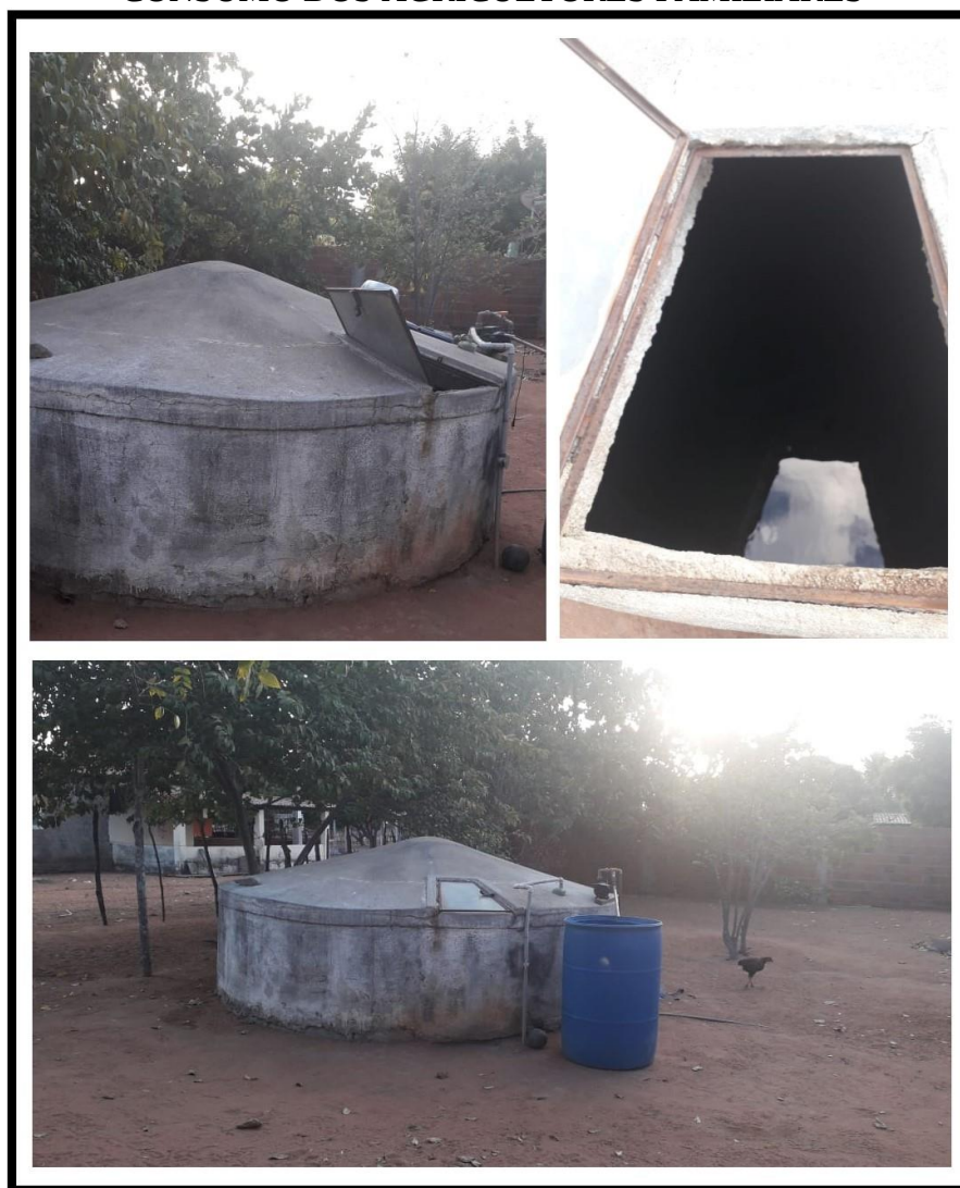
Figura 5 – CISTERNA DESTINADA AO ARMAZENAMENTO DE ÁGUA PARA O CONSUMO DOS AGRICULTORES FAMILIARES
