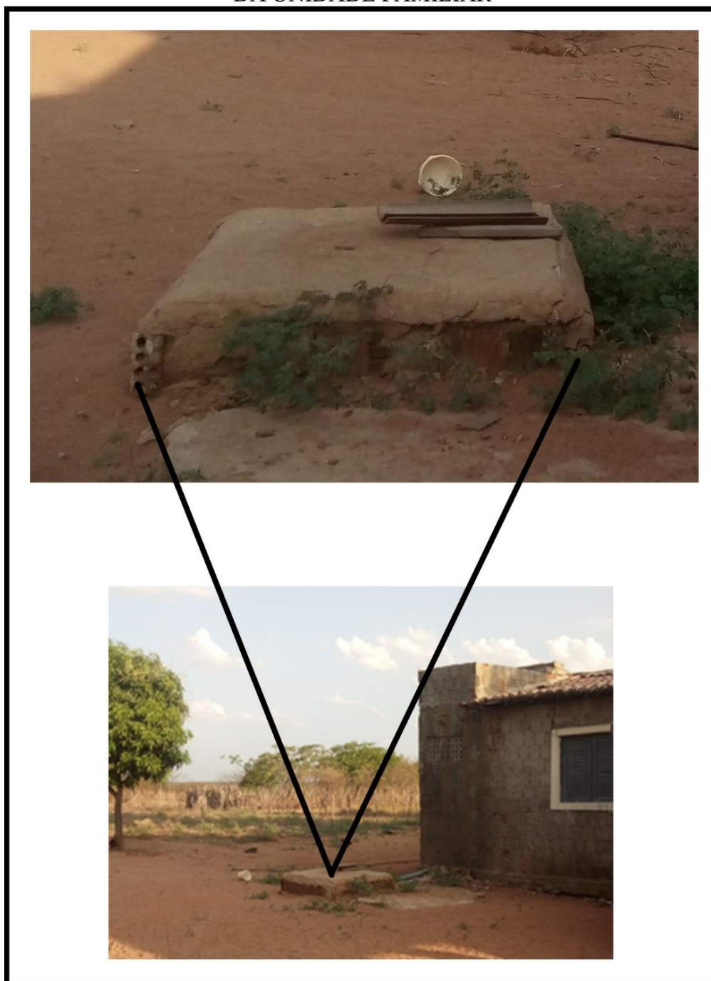
Figura 10 – FOSSA SÉPTICA USADA PARA DEPOSITAR OS RESÍDUOS LÍQUIDOS DA UNIDADE FAMILIAR
