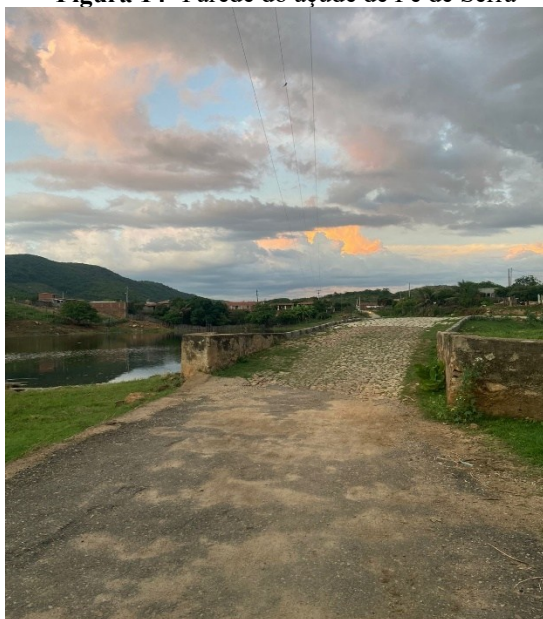
Figura 14- Parede do açude de Pé de Serra
