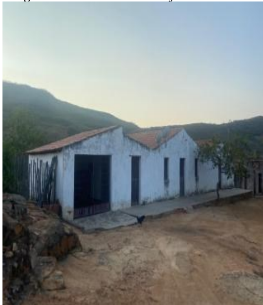
Figura 79- Casa de JR com tijolo de caeira
