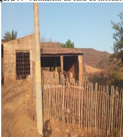
Figura 99- Armazém da casa de moradora
