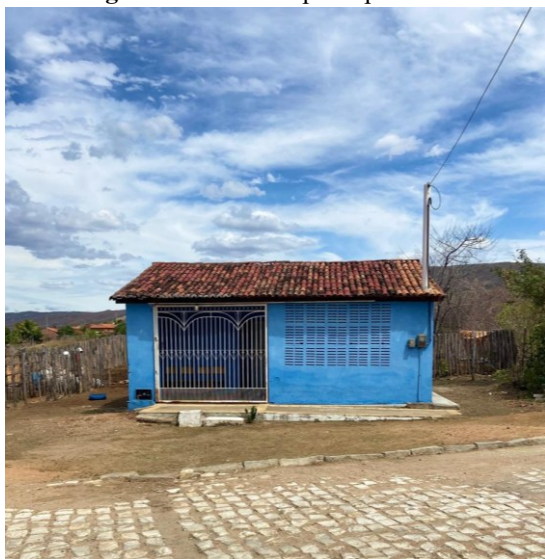
Figura 24- Fachada principal da escola
