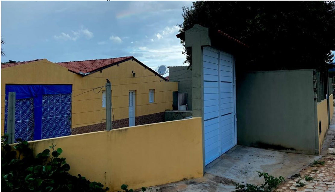
Figura 70- Casa amarela do setor de baixo
