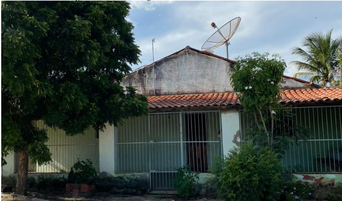
Figura 64- Vista da antiga escola da comunidade de Pé de Serra
