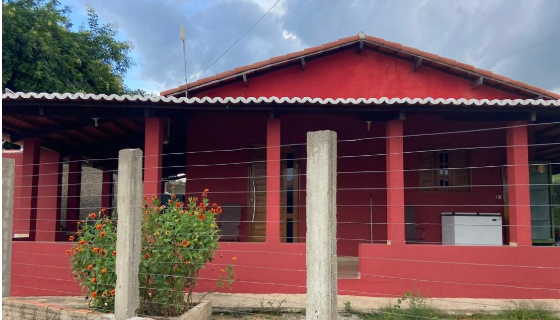
Figura 62- Casa do setor do meio da comunidade
