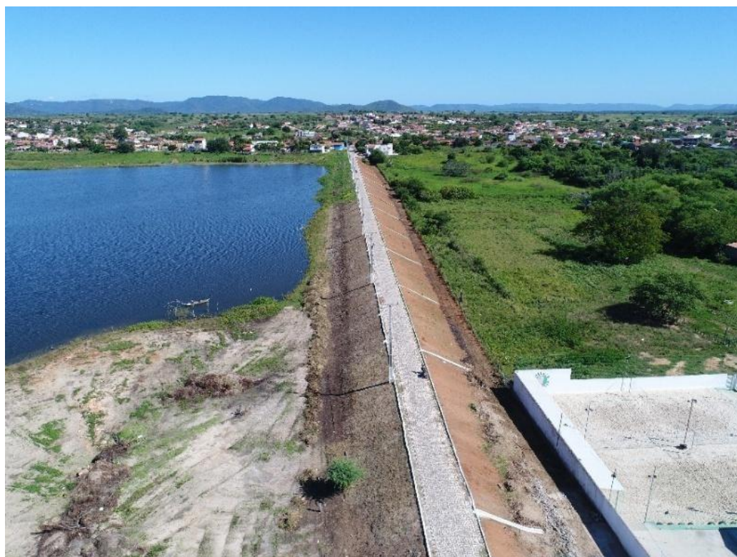
Figura 6 – Estrutura dos taludes de montante, jusante e o coroamento da barragem da vinte e cinco de Março em Pau dos Ferros-RN
