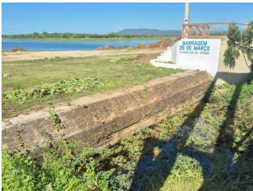
Figura 7 – Vertedouro da barragem vinte e cinco de Março
