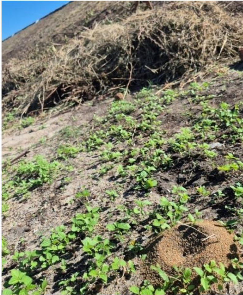
Figura 13 – Presença de formigueiros no talude de jusante da estrutura
