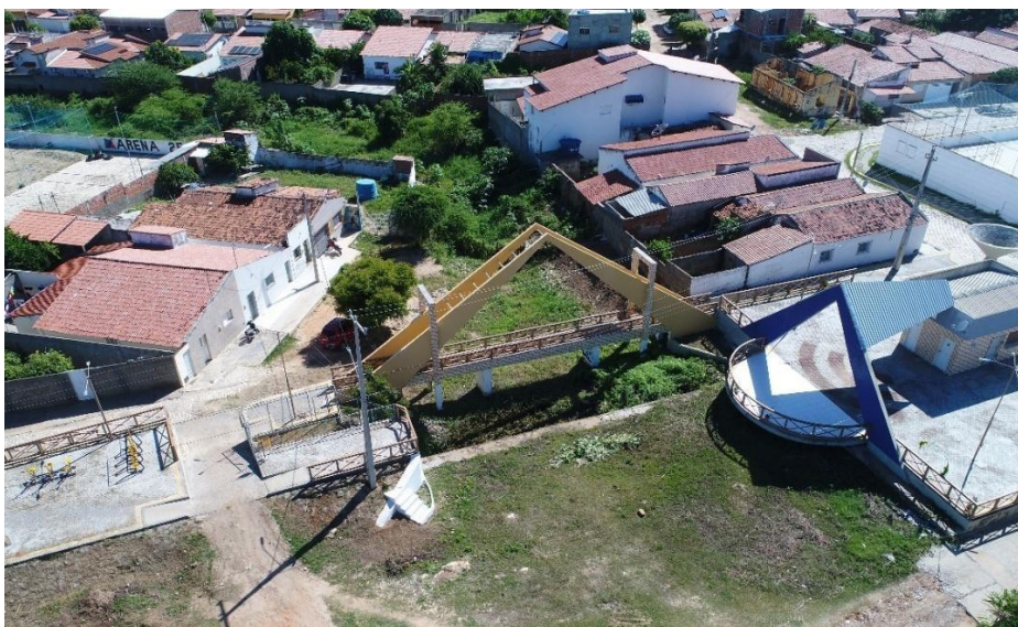
Figura 9 – Habitações edificadas dentro da APP no entorno da barragem da vinte e cinco de Março
