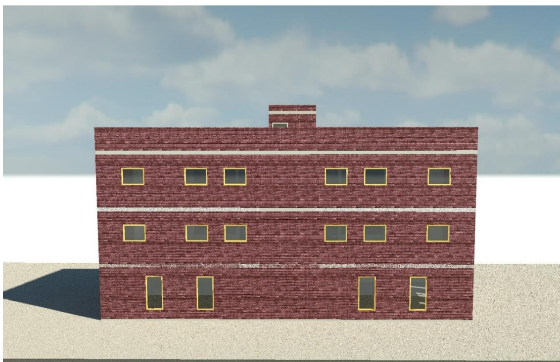
Figura 07 - Fachada lateral esquerda.
