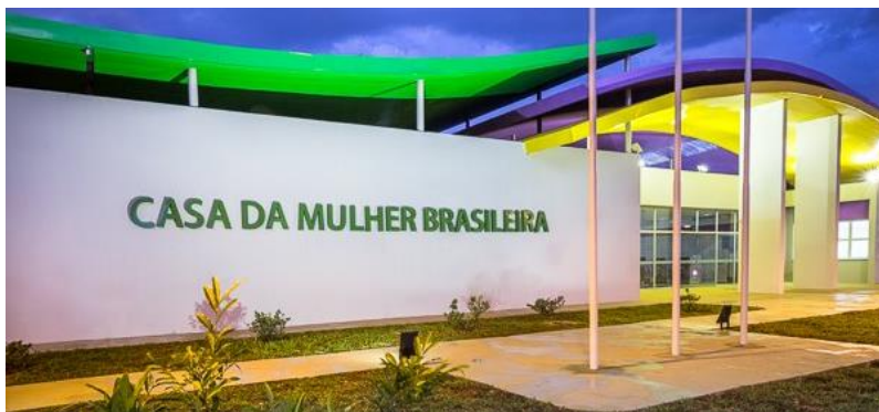
Figura 14: Fachada da edificação - Casa da Mulher Brasileira/ CMB – Brasil
