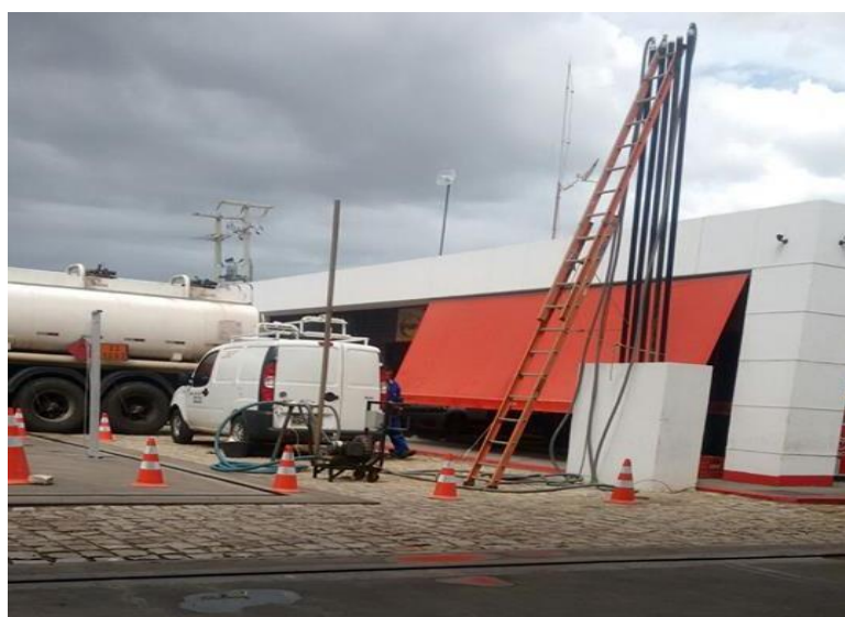
Figura 14 - Realização de teste de estanqueidade de um posto em Mossoró.
