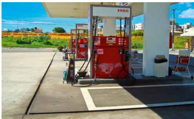
Figura 7 - Piso da área dos tanques em concreto impermeável circundado por canaletas.
