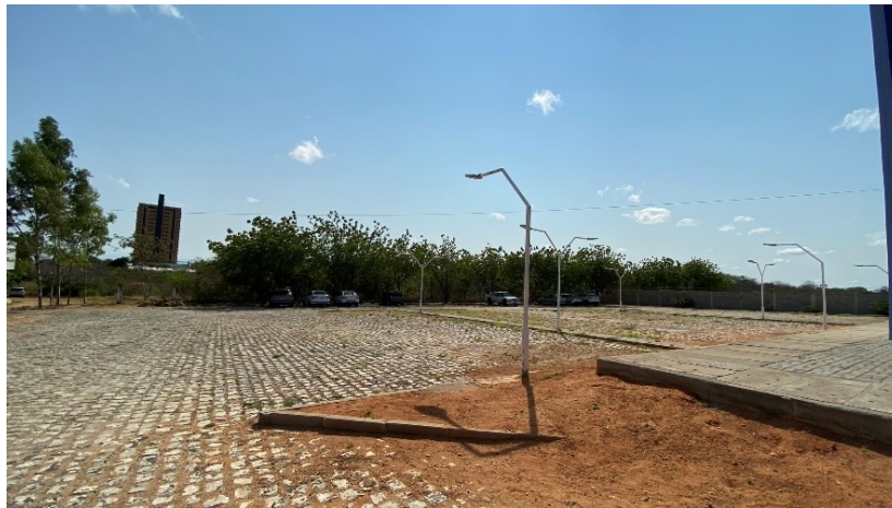
Figura 12 – Estacionamento (Lateral esquerda)
