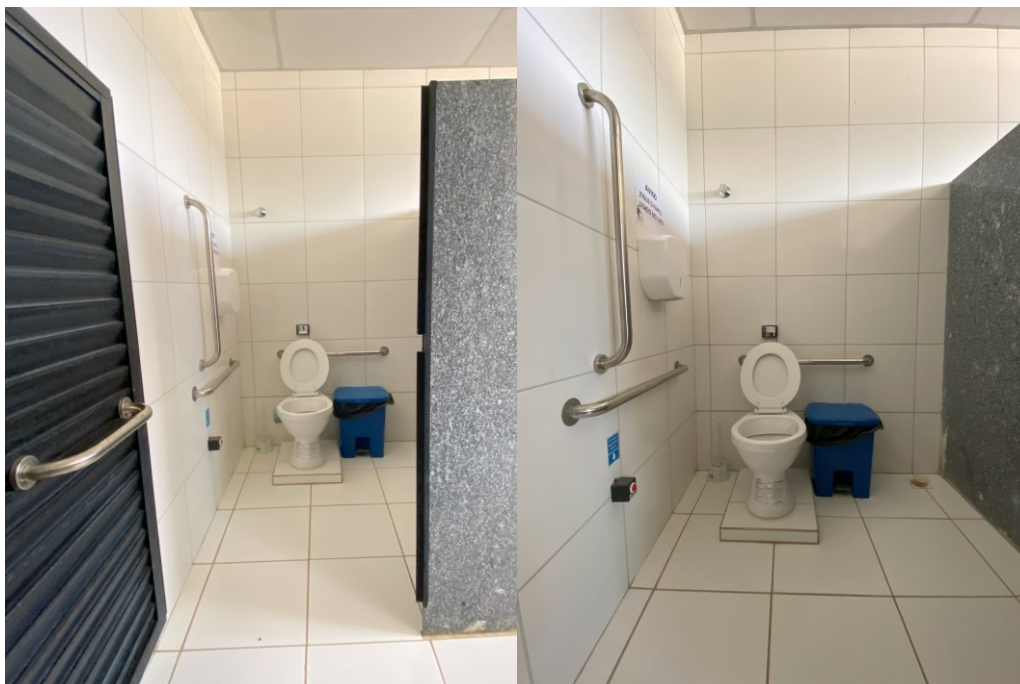
Figura 33 – BOXE SANITÁRIO ACESSÍVEL FEMININO - TÉRREO
