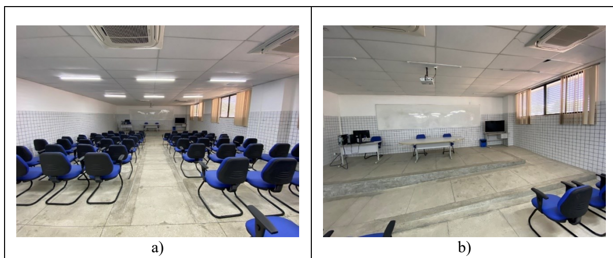
Figura 19 – Rampas do auditório – a) rampa central; b) rampas de acesso ao palco
