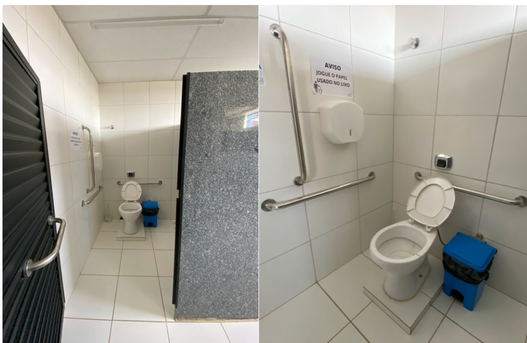
Figura 36 - BOXE SANITÁRIO ACESSÍVEL FEMININO – 3º PAVIMENTO
