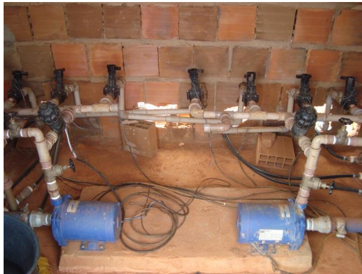
Figura 5 - Composição dos conjuntos motobomba utilizada no experimento. Fonte: Autor (2013).
