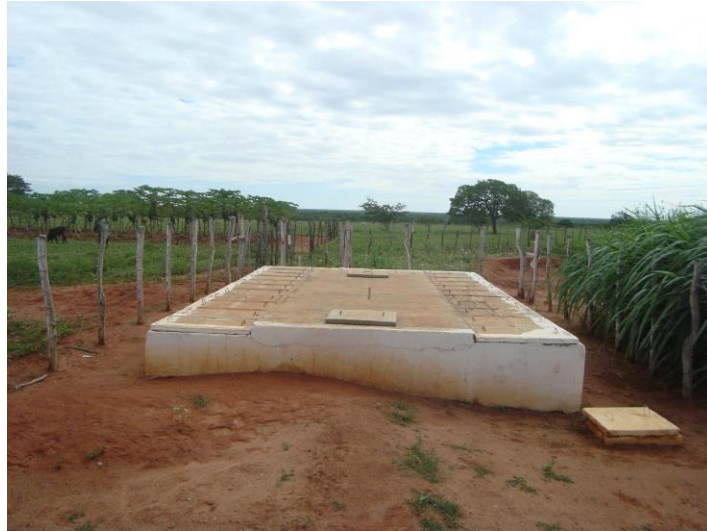
Figura 2 - Vista frontal do decanto-digestor existente no Assentamento Milagres em Apodi-RN. Fonte: Autor (2013).
