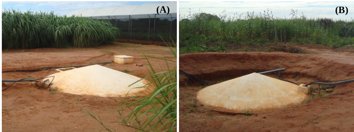
Figura 3 - Reservatórios do esgoto doméstico primário (A) e da água de abastecimento (B). Fonte: Autor (2013).
