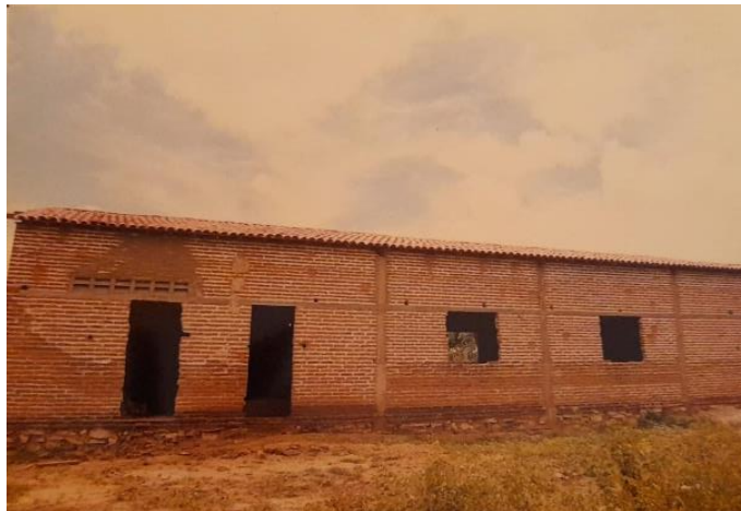
Figura 23- Fachada Lateral da Igreja de Cristo em fase de construção
