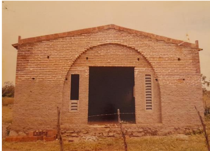
Figura 22- Fachada Frontal da Igreja de Cristo em fase de construção
