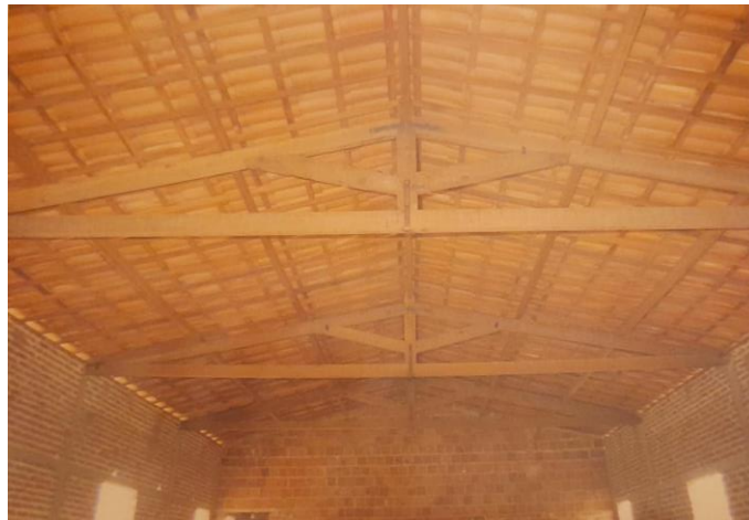
Figura 24- Cobertura da Igreja de Cristo em fase de construção
