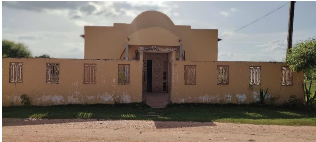
Figura 26- Fachada frontal com muro em 2022
