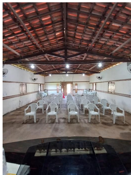
Figura 32- Vista interna 02 do salão da igreja
