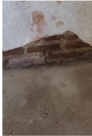
Figura 45- Composição da parede
