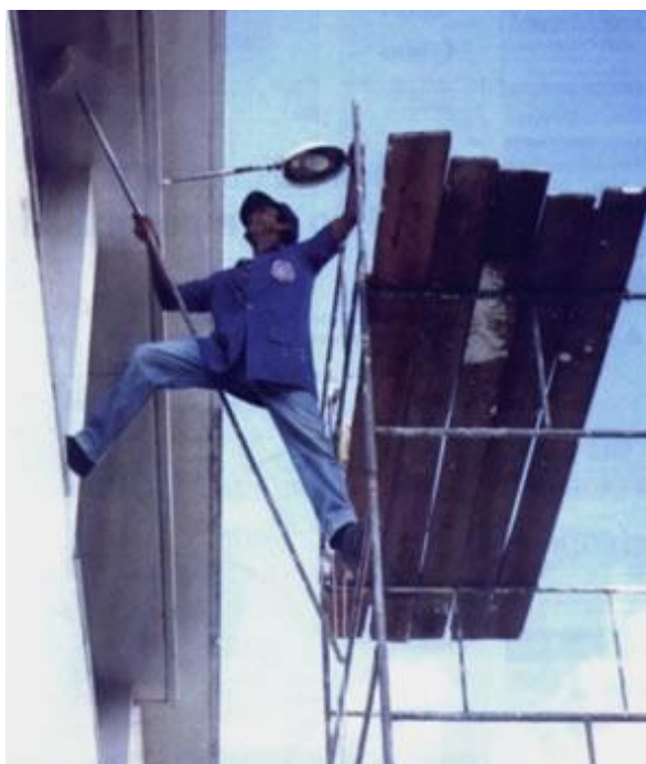
Figura 1 - Trabalhador improvisa acesso ocasionando ato inseguro
