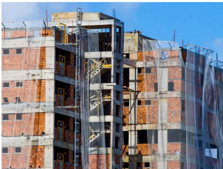
Figura 7 - Rede é um dos EPCs utilizados na construção civil para minimizar as consequências de quedas de pessoas e ferramentas
