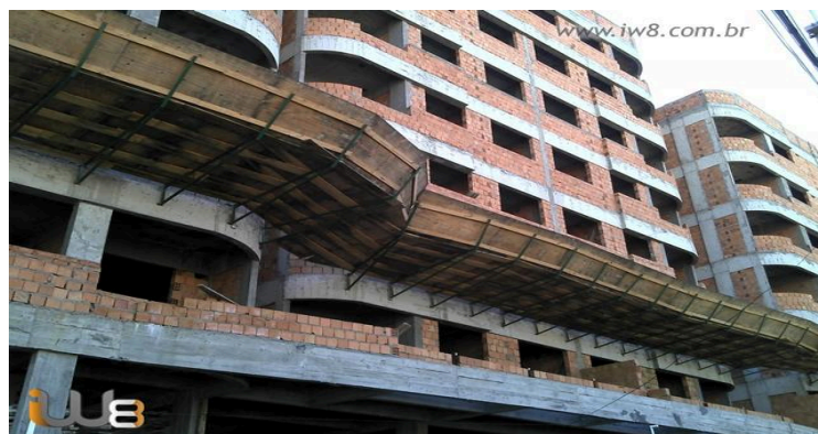
Figura 10 - Plataforma principal utilizada em edifícios na construção civil
