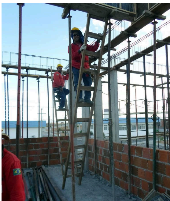
Figura 17 - Trabalhadores fazendo uso de escada em canteiro de obras da UFERSA Campus Caraúbas/RN
