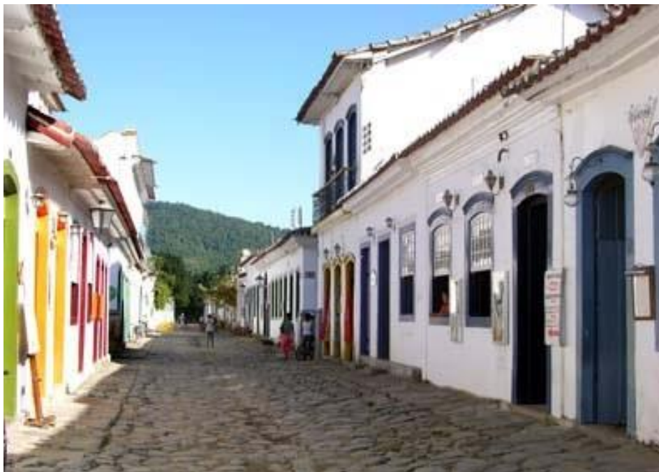
Figura 3: Rua de pavimento com pedras pé-de-moleque localizada na cidade de Paraty/RJ.
