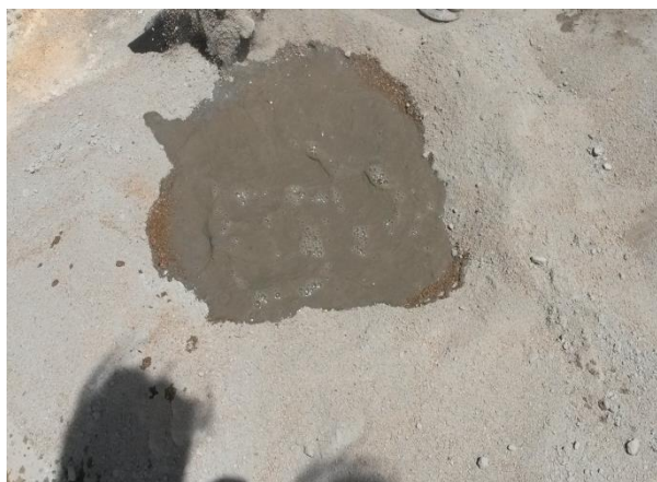
Figura 15: Mistura manual dos materiais para formação da massa de concreto.
