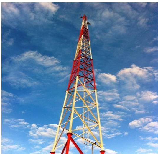
Figura 1: Torre autoportante.
