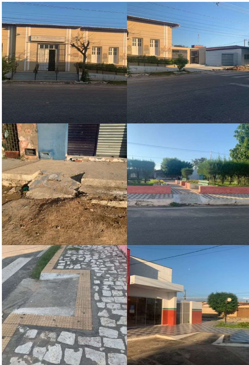
Figura 1: Corrimões, rampas e piso tátil.
