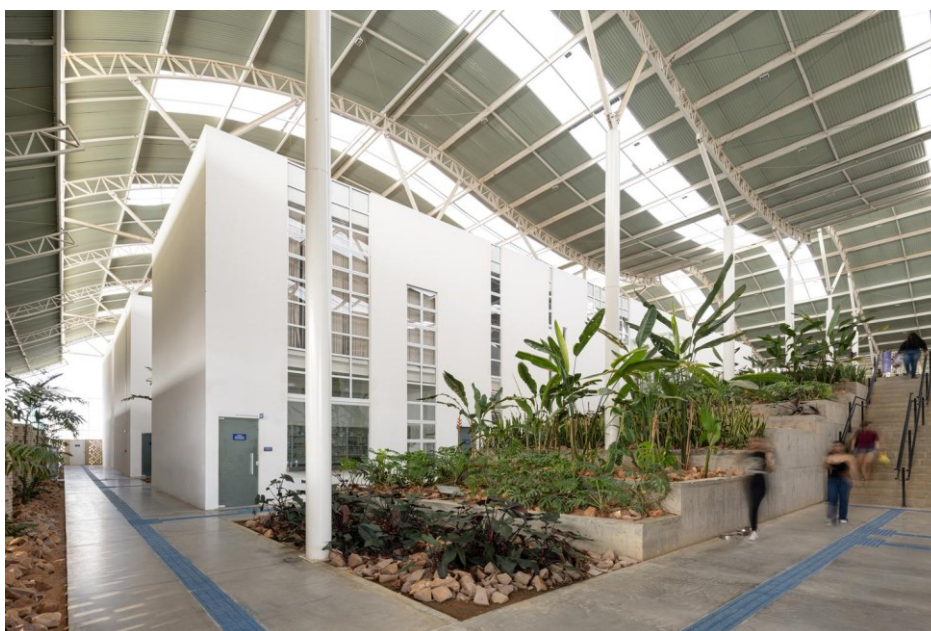
Figura 23 - Jardins Sobre o Muro de Arrimo
