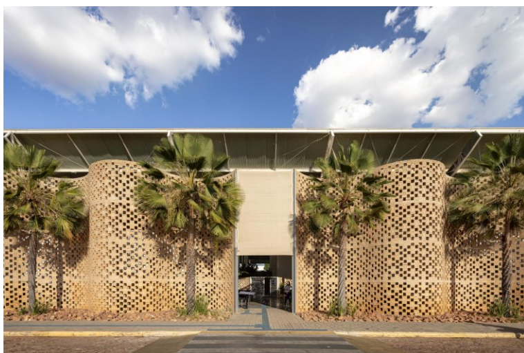
Figura 21 - Fachada do Hospital Veterinário Escola da Unileão
