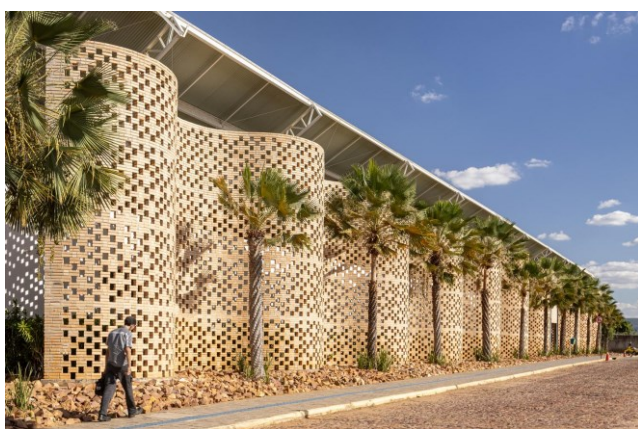
Figura 26 - Vista Frontal do Muro.
