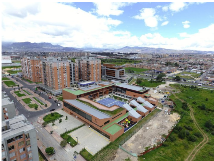
Figura 7 - Vista Geral do Colégio
