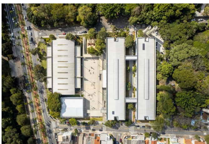
Figura 19 - Vista Superior da Edificação
