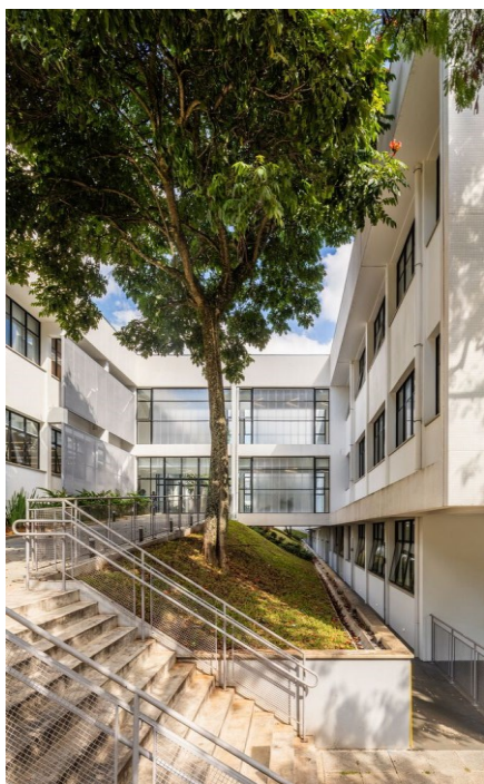
Figura 18 - Vista Interna da Edificação
