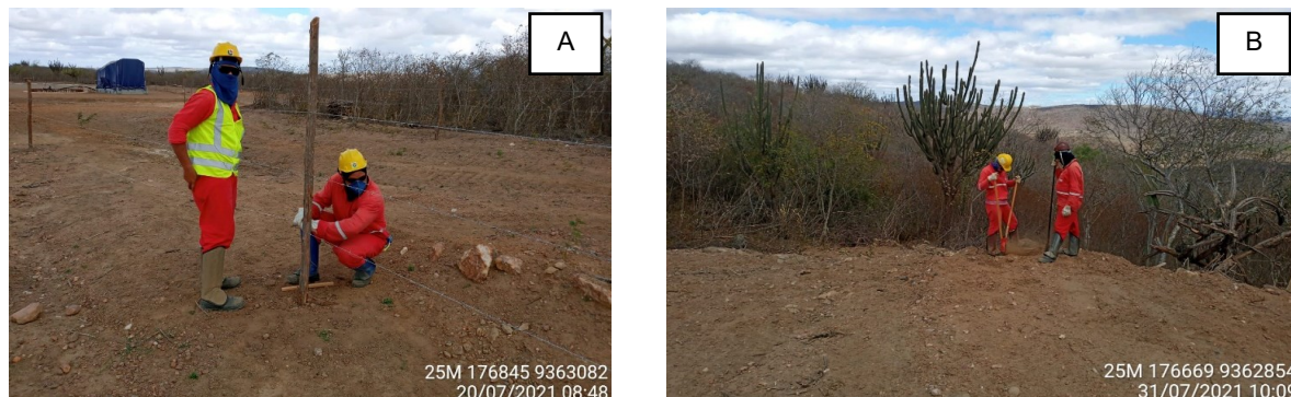
Figura 4 (A e B). Cercamento da área de RAD.
