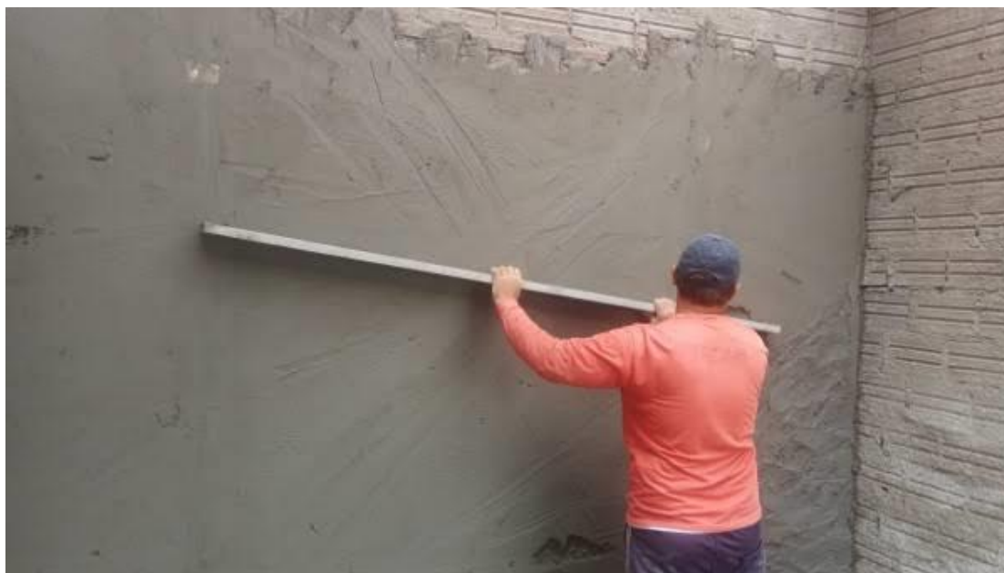
Figura 3 – Execução do revestimento argamassado.
