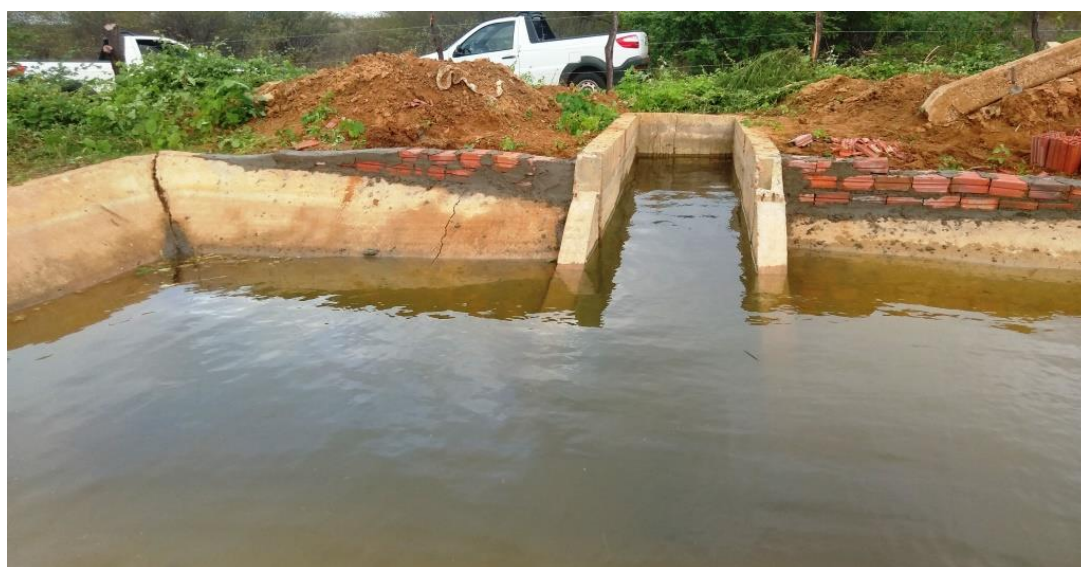
Figura 15: Reparo no Canal (Alto do Rodrigues/ /RN). Fonte: Aldifran, 2021.
