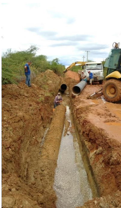
Figura 13: Reparo na adutora Setor 02 (Alto do Rodrigues/ /RN). Fonte: Aldifran, 2021.
