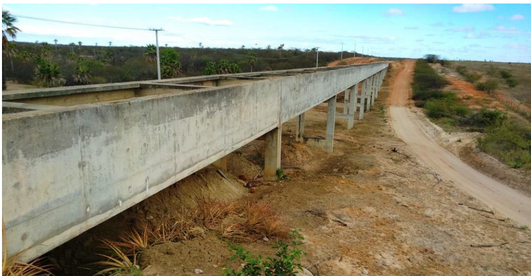
Figura 22: Aqueduto no canal 2ª Etapa (Afonso Bezerra/ /RN). Fonte: Aldifran, 2021.
