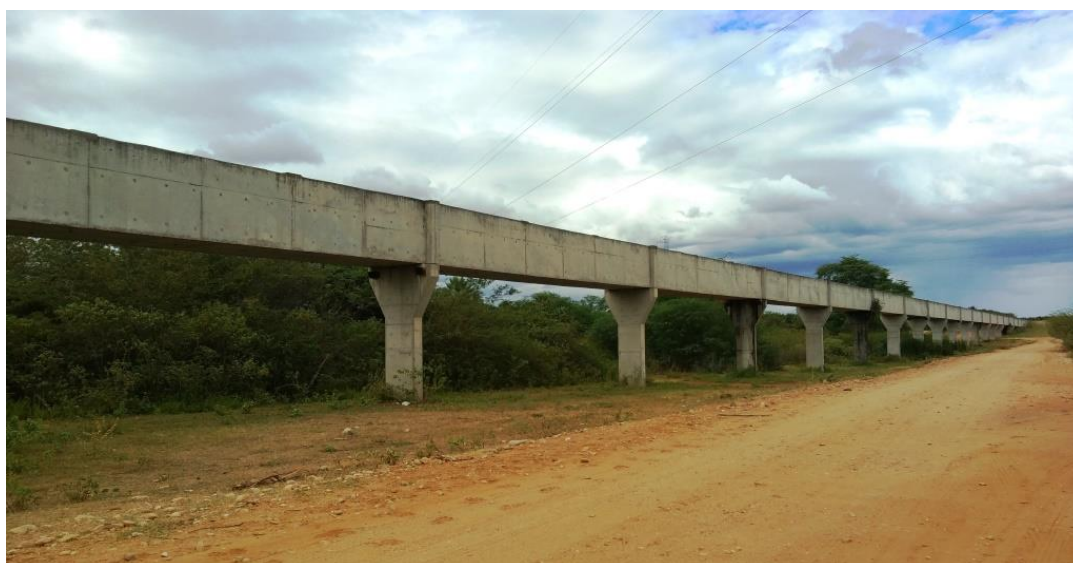
Figura 21: Aqueduto no canal principal MDE distribuição de água da 1ª etapa (Alto do Rodrigues/ RN). Fonte: Aldifran, 2021.
