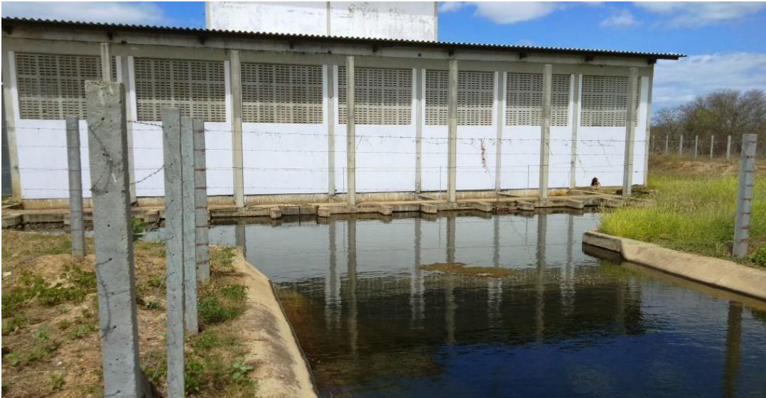
Figura 16: Estação Elevatória 2ª Etapa (Afonso Bezerra/ RN). Fonte: Aldifran, 2021.
